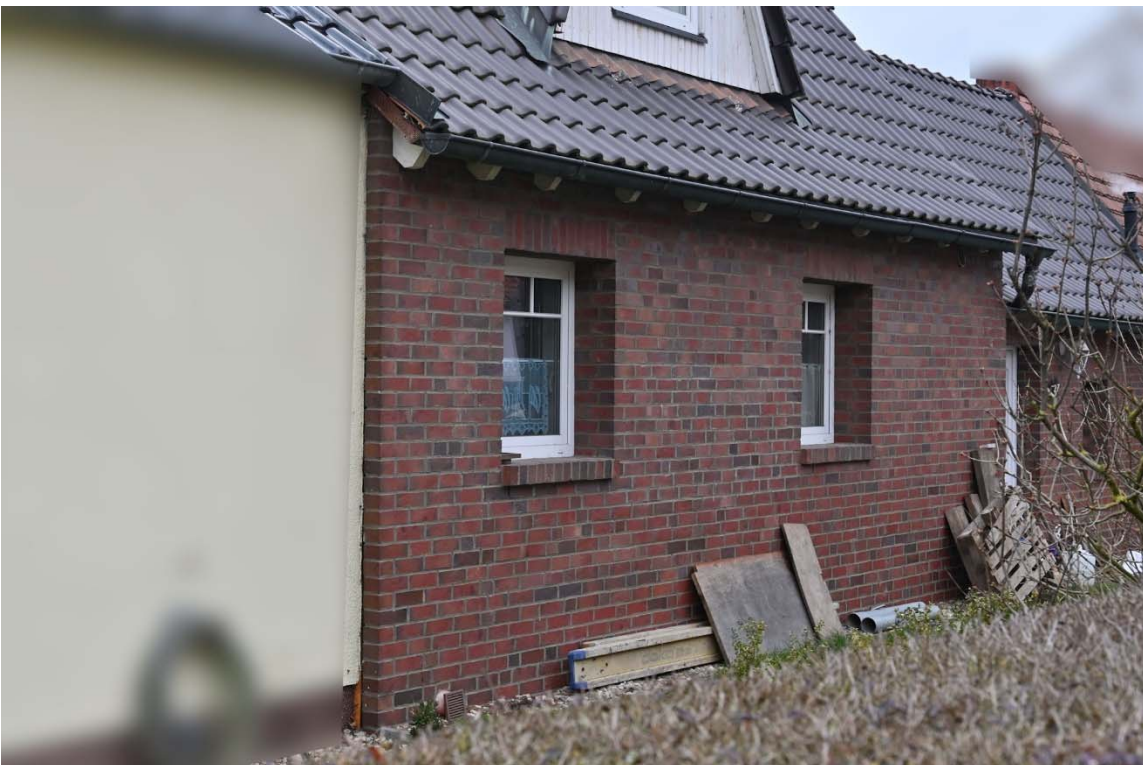
Abb. 8: Gebäudeansicht von der Straße, Detail Vorsatzschale Vollklinker
