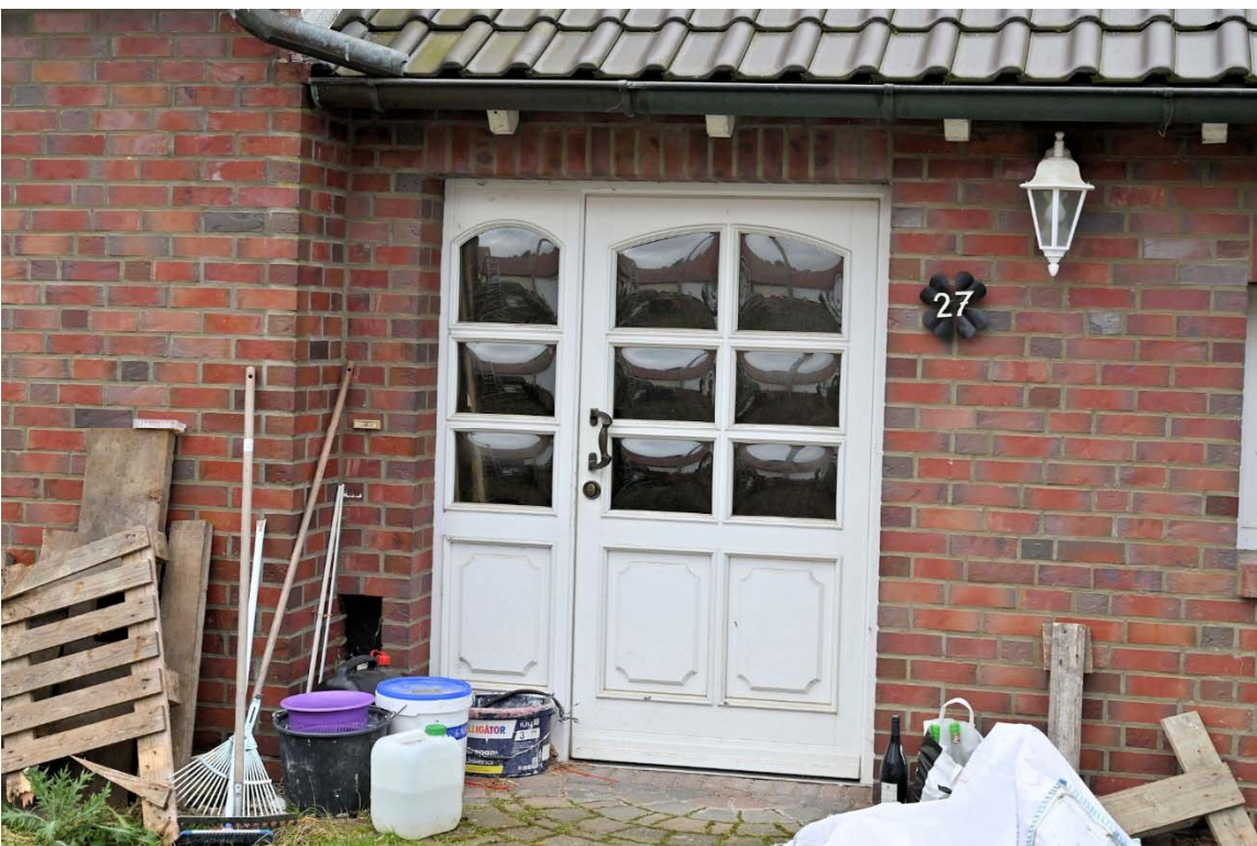
Abb. 4: Gebäudeansicht von der Straße, Detail Hauseingangstür
