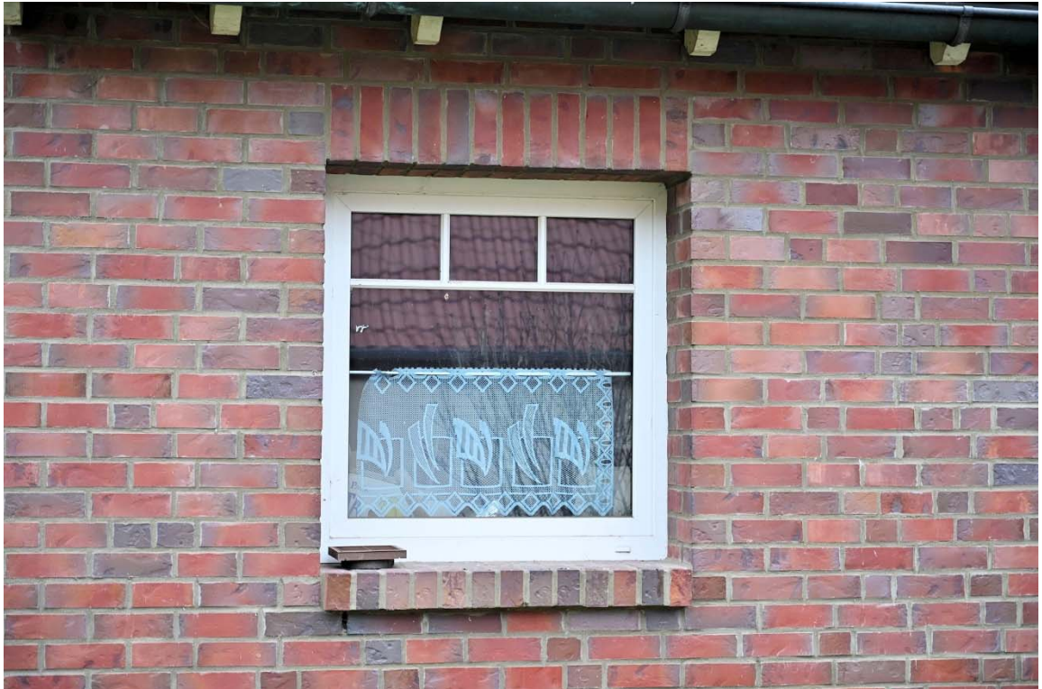
Abb. 9: Gebäudeansicht von der Straße, Detail Fenster
