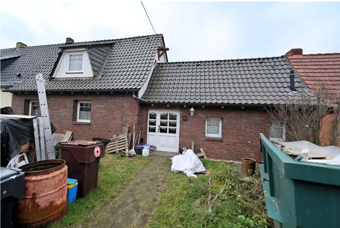
Abb. 3: Gebäudeansicht von der Straße
