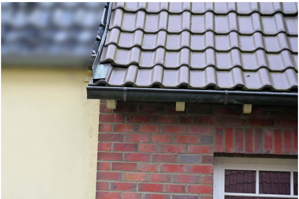
Abb. 10: Gebäudeansicht von der Straße, Detail Abschlussblech Ortgang
