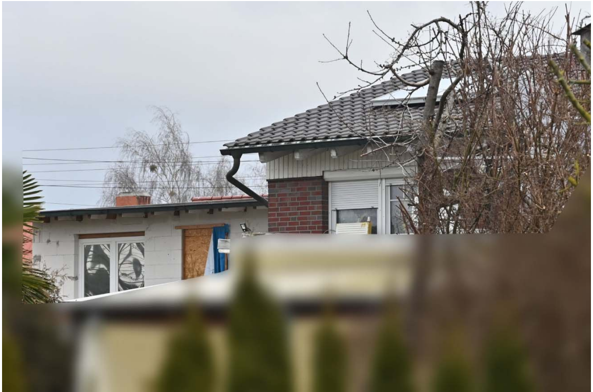
Abb. 13: rückseitige Gebäudeansicht von der Straße
