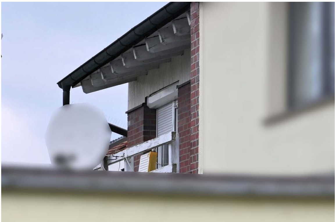
Abb. 14: rückseitige Gebäudeansicht von der Straße, Detail Balkon
