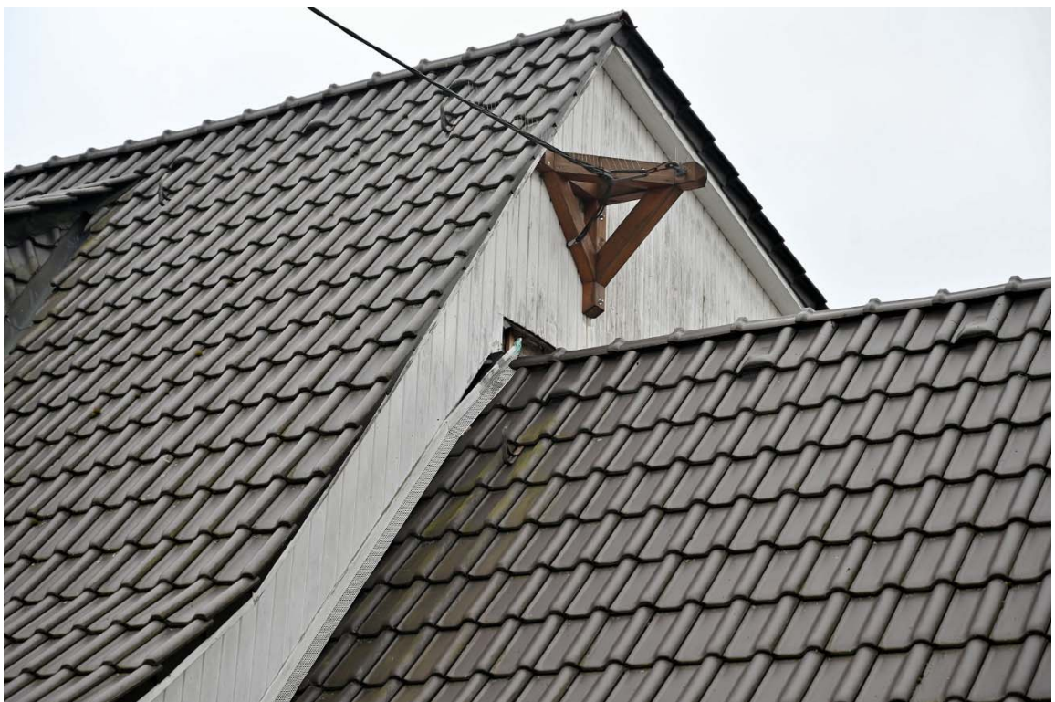
Abb. 6: Gebäudeansicht von der Straße, Detail Giebelverschalung u. a.
