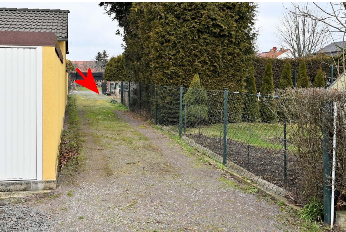
Abb. 12: Zufahrt zum Garten über Fremdgrundstück und Weg über Bewertungsobjekt (beides dinglich ungesichert), Kennzeichnung Bewertungsobjekt
