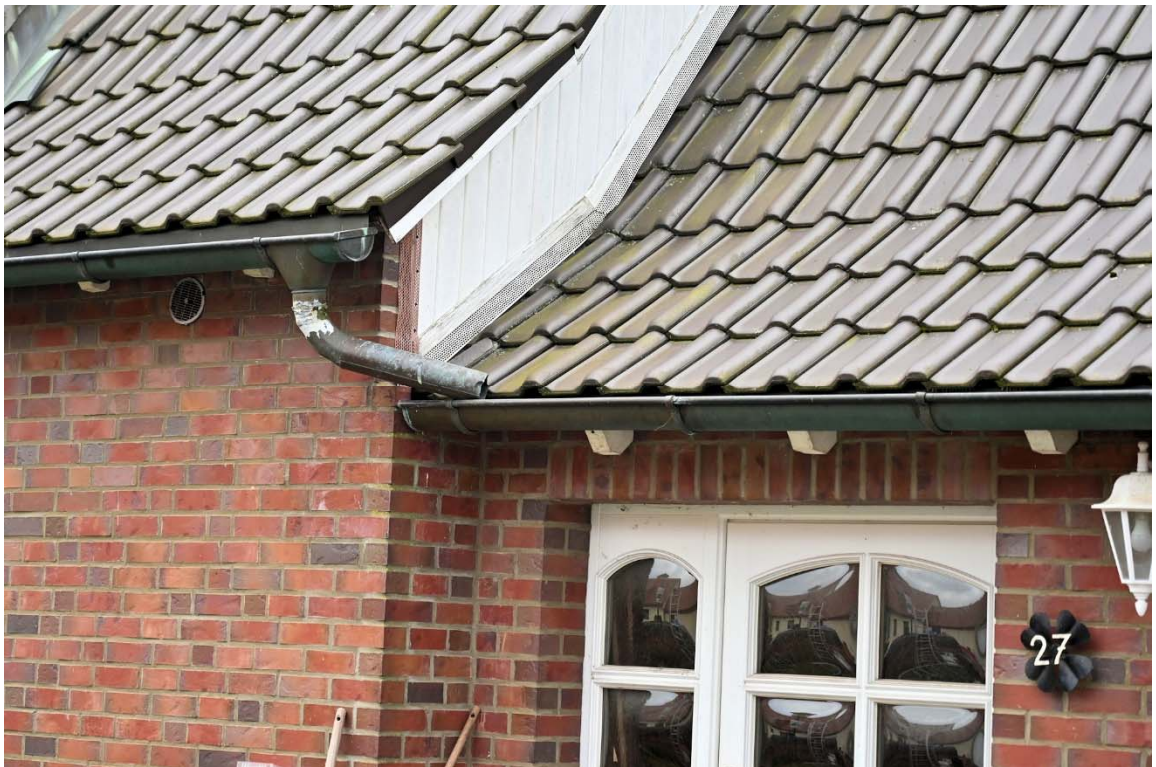
Abb. 5: Gebäudeansicht von der Straße, Detail Dachentwässerung u. a.
