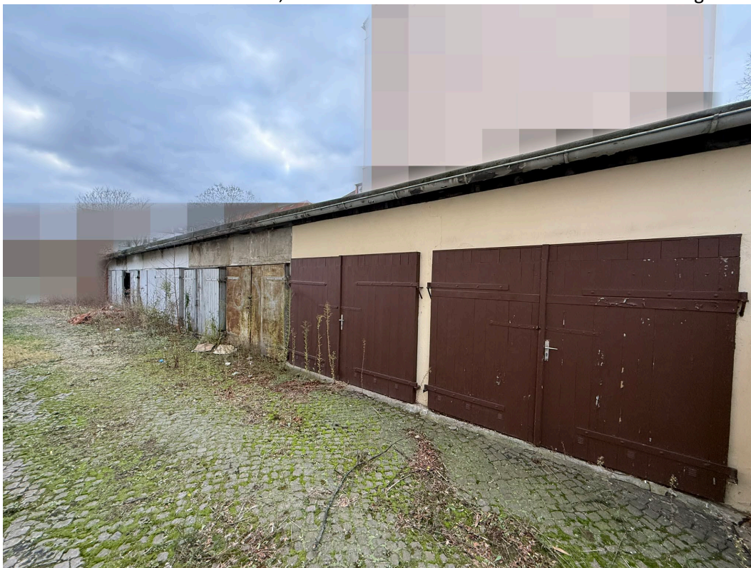
vorhandene Garagenzeile auf dem Wertermittlungsgrundstück (Liquidationsobjekt)
