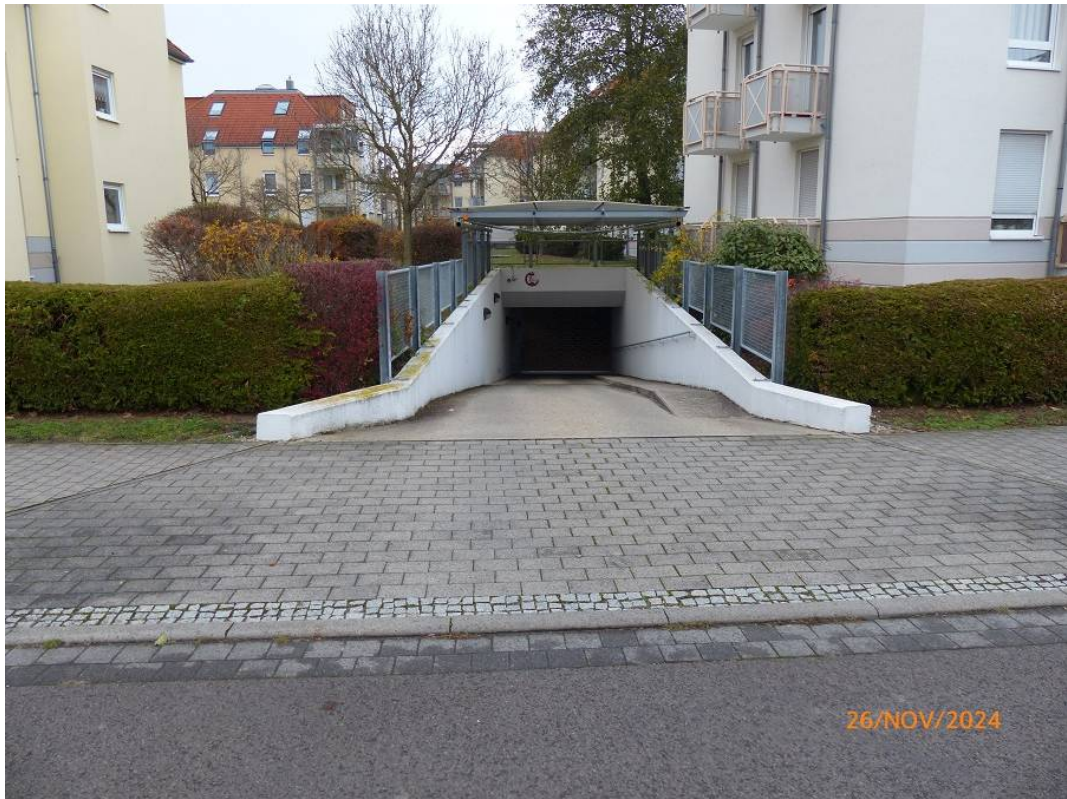
Foto 23: Tiefgarageneinfahrt im Außenring zwischen Haus Nr. 22 und 24
