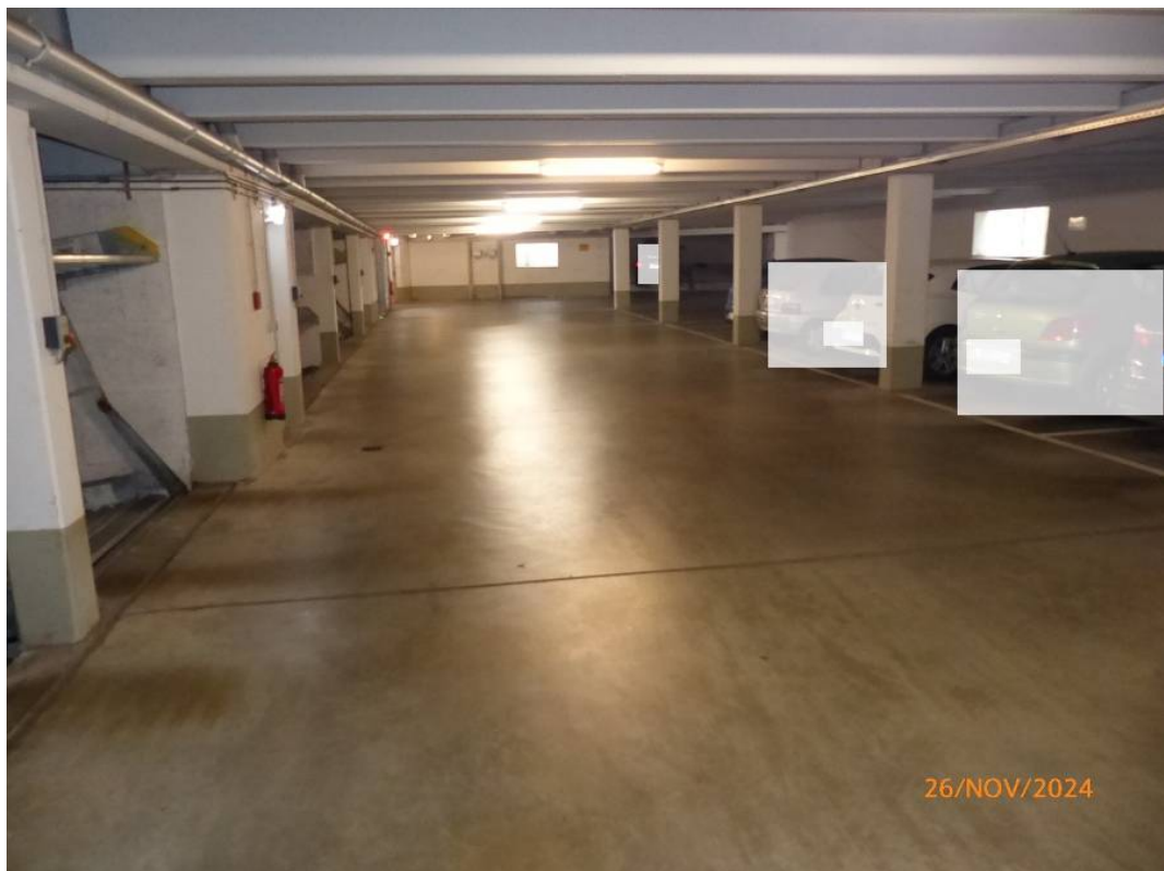
Fotos 19 und 20: Tiefgarage der Wohn- und Teileigentumsanlage (GE)
