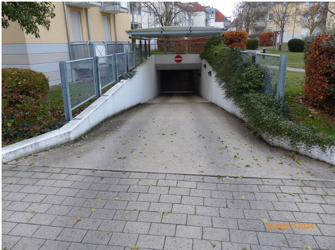
Foto 24: Tiefgaragenausfahrt im Außenring zwischen Haus Nr. 26 und 28
