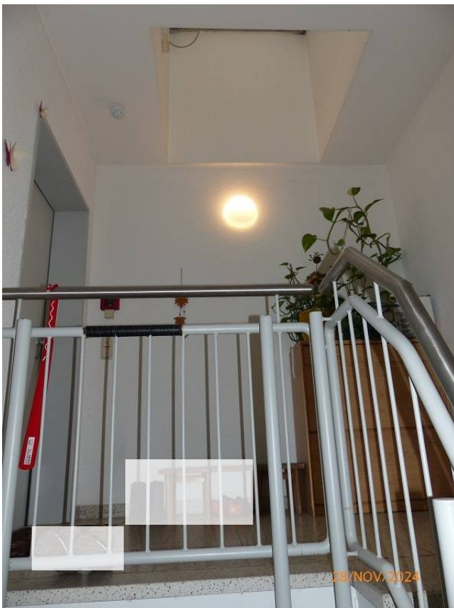
Fotos 17 und 18: TH im 2. Dachgeschoss (GE)
