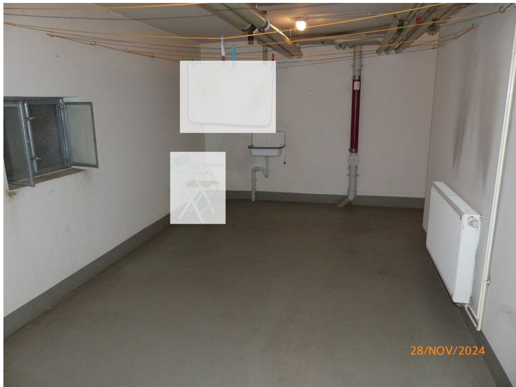
Foto 13: Trockenraum im Keller (GE)
