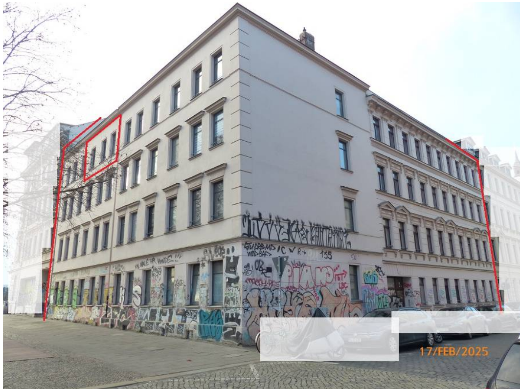
Foto 5: Straßenansicht Wohneigentumsanlage Helmholtzstraße 20, 22, 22a, WE Nr. 8 (Gemeinschaftseigentum)
