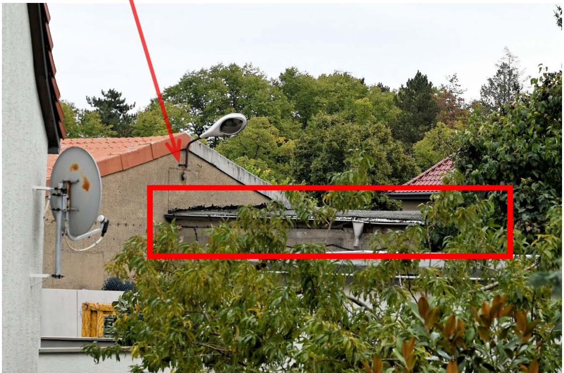
Abb. 10: Gebäude D, Ansicht von der Straße, vor Gebäude tw. die Ausübungsfläche zur Abstandsflächenbaulast, Kennzeichnung Bewertungsobjekt (Rechteck)
