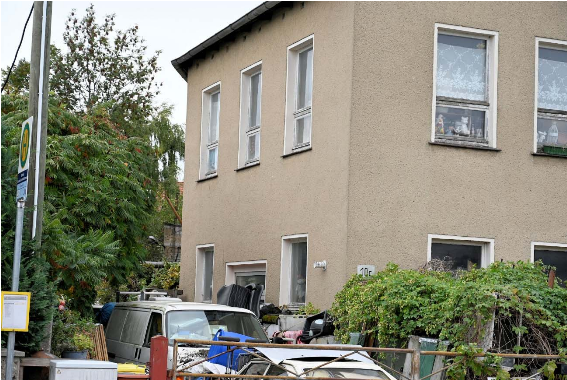
Abb. 3: Gebäude A, Detailansicht
