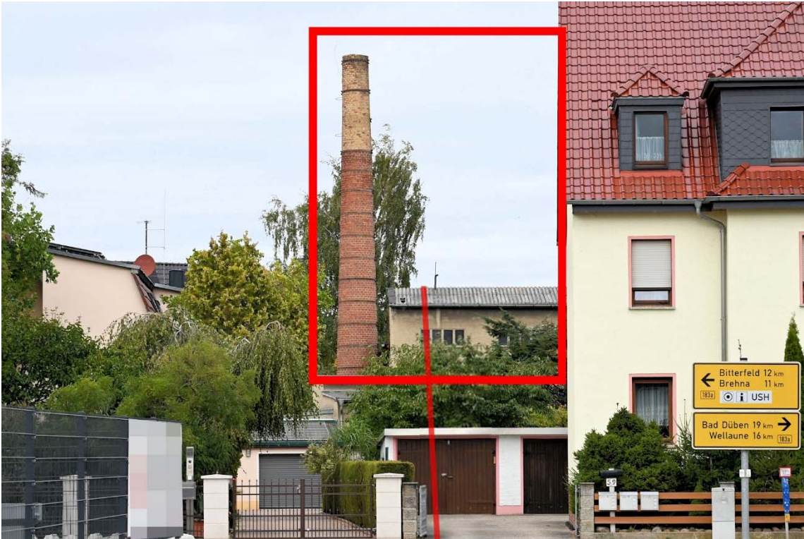
Abb. 11: Gebäude C und Industrieschornstein von der Dübener Straße, Kennzeichnung Bewertungsobjekt
