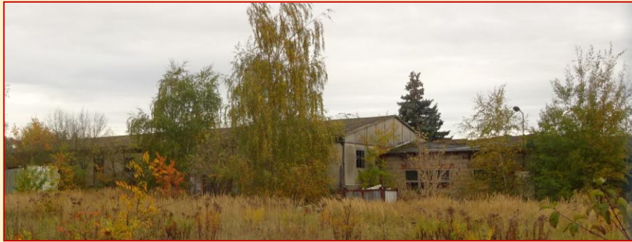
Blick auf die abrisssreife ehemalige Kartoffelhalle auf Flst. 2/1
