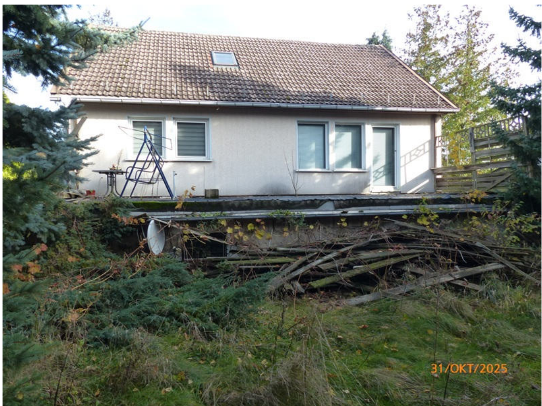
Foto 7: EFH - Ansicht Westseite
