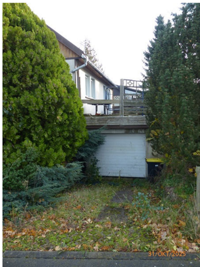
Foto 11: Zufahrt Garage im Siedlerweg
