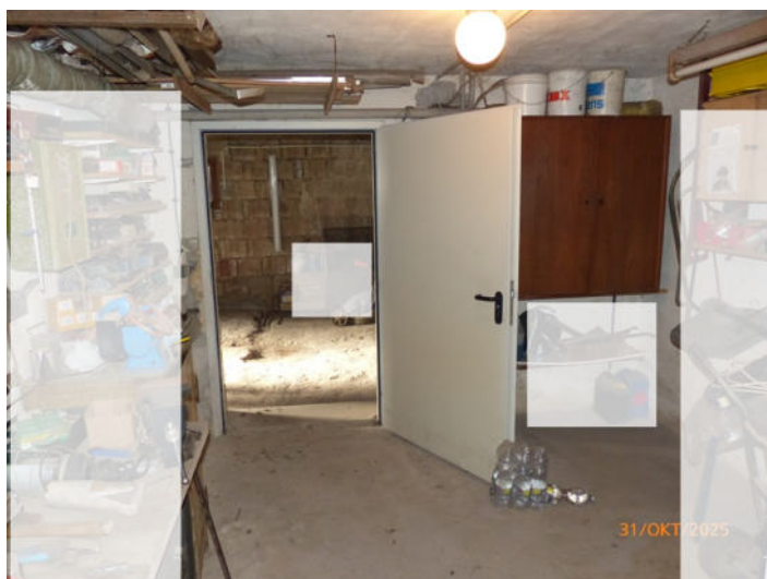
Fotos 61 und 62: Tür vom Keller zur Garage (oben: Richtung Garage/unten: Richtung Keller)
