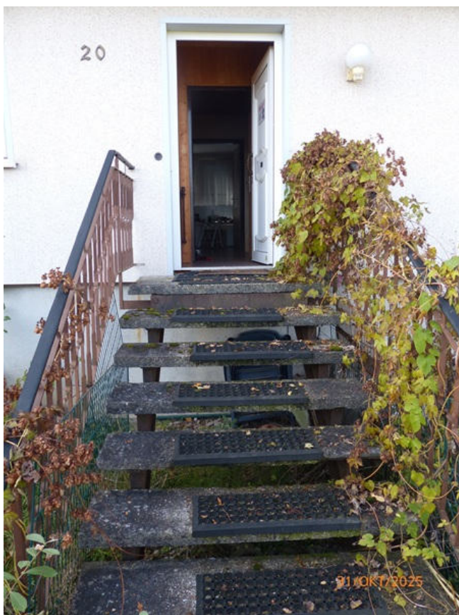
Fotos 12 und 13: Hauseingang / Windfang und Diele
