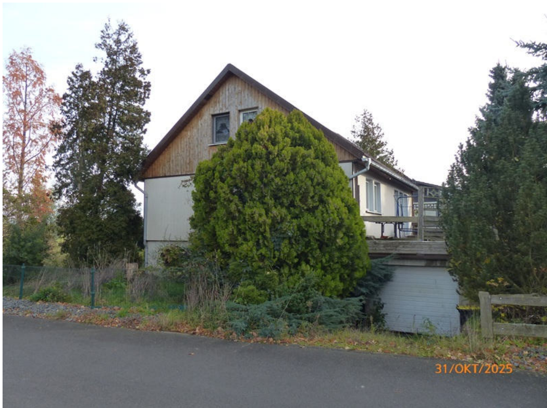
Foto 8: EFH - Ansicht Nordgiebel und Garagenanbau
