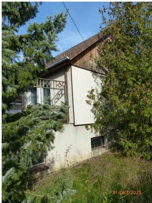
Foto 9: EFH – Ansicht Südgiebel und Garagenanbau
