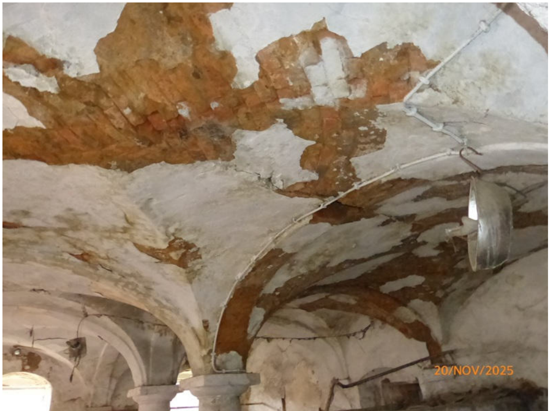
Foto 38: Erdgeschoss – Kreuzgewölbe im Stallbereich
