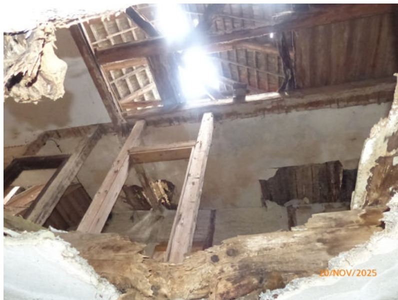
Foto 66: Blick durch die eingebrochenen Decken in das OG und den Dachboden
