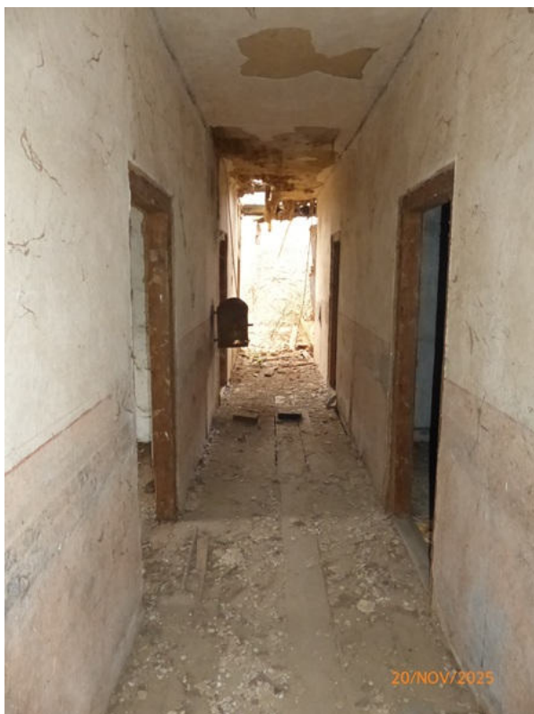
Fotos 48 und 49: Obergeschoss - Flur im westlichen Bereich
