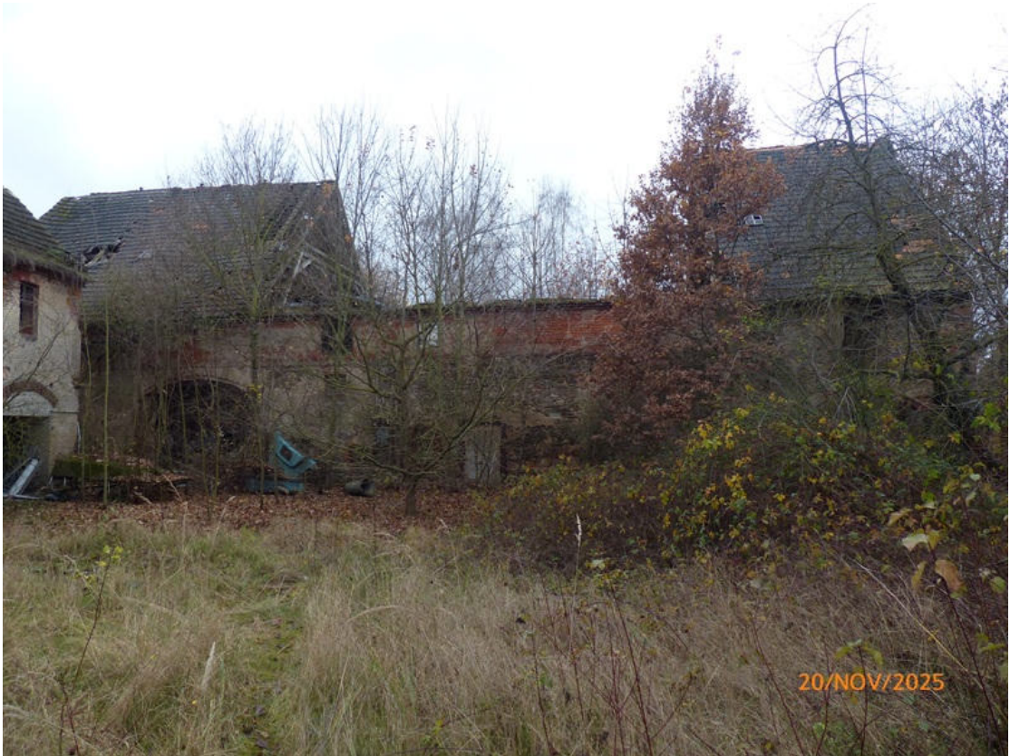
Foto 67: Ansicht Scheune – Ostseite (Hofbereich)
