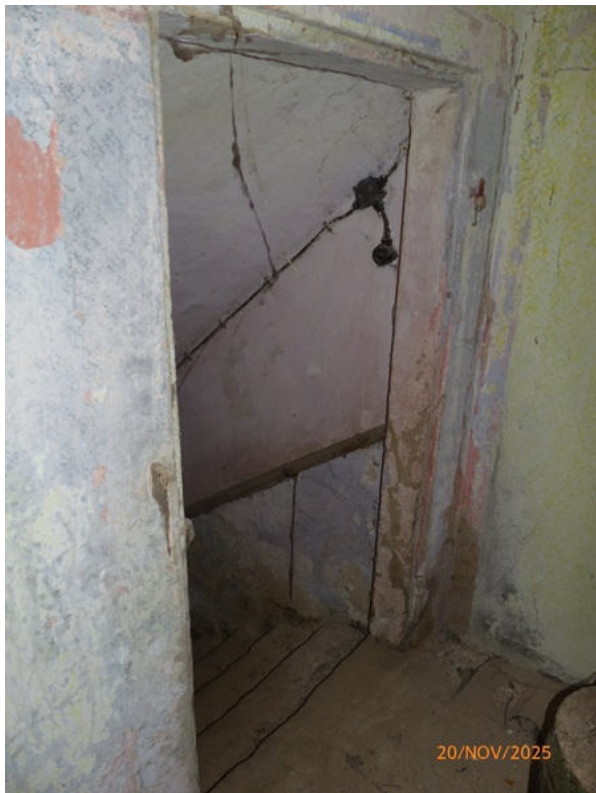
Foto 39 und 40: Treppe in den Keller
