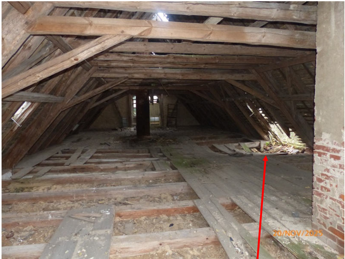
Fotos 54 und 55: Dachboden - Blick Richtung Ostgiebel
