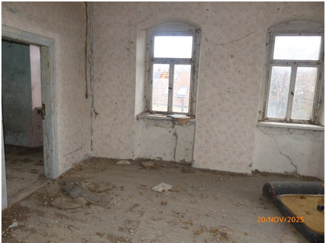
Foto 47: Raum im Obergeschoss – östlicher Bereich
