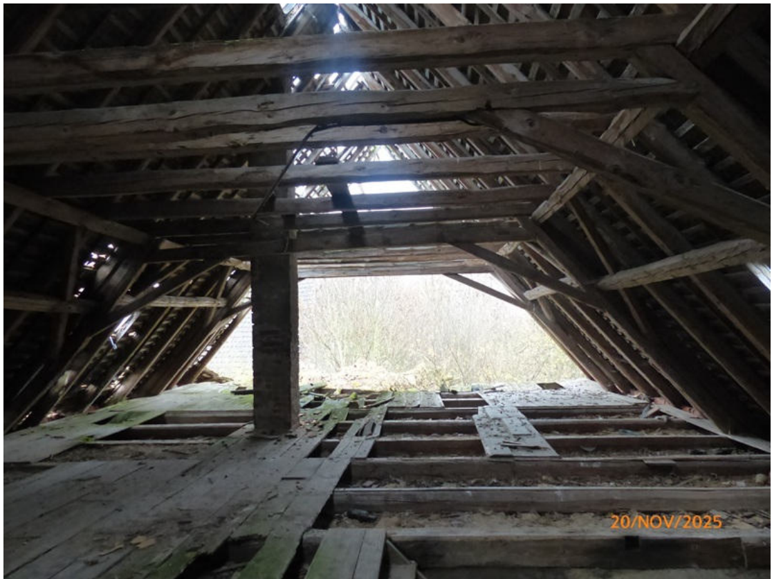
Fotos 56 und 57: Dachboden - Blick Richtung Westgiebel
