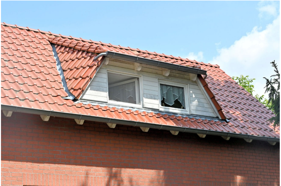
Abb. 5: Am Morkaberg 3, südliche Traufe, Dachgaube
