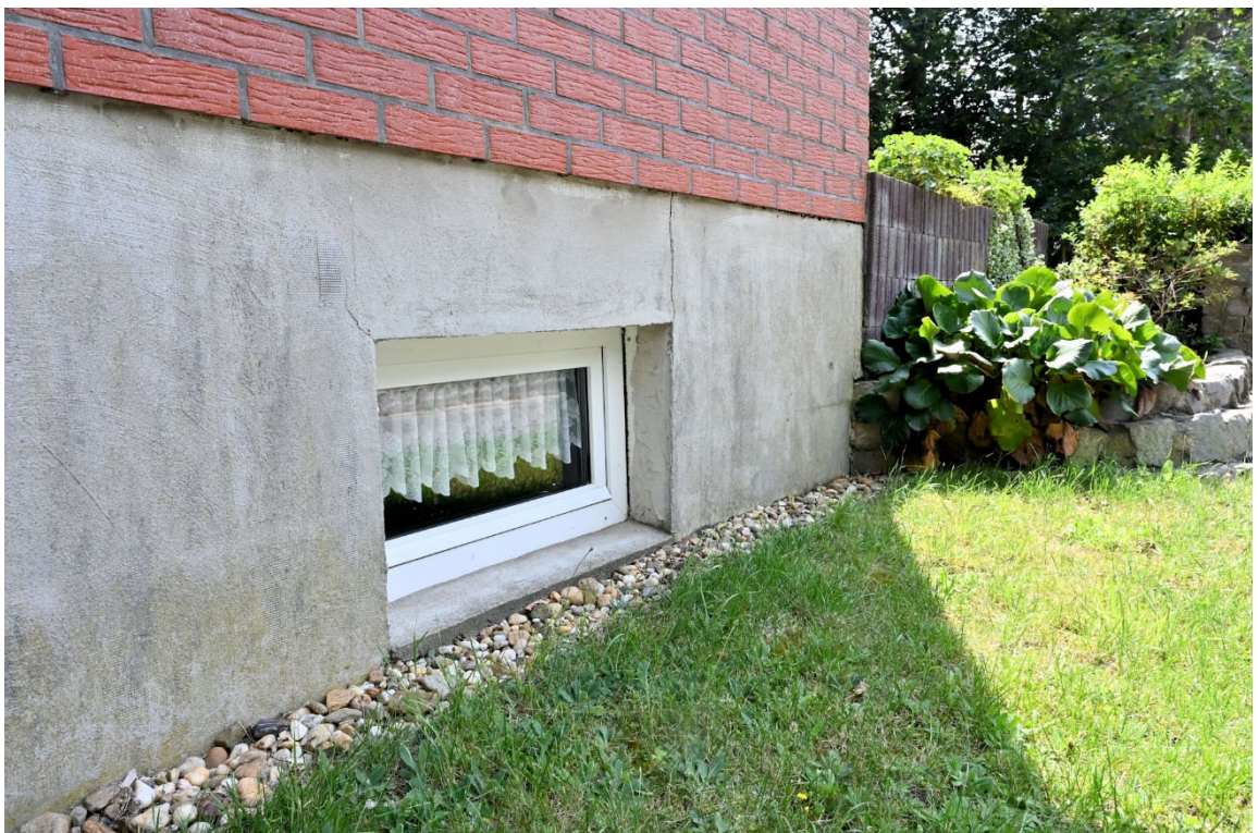
Abb. 6: Am Morkaberg 3, westlicher Giebel, Detail Sockelputz
