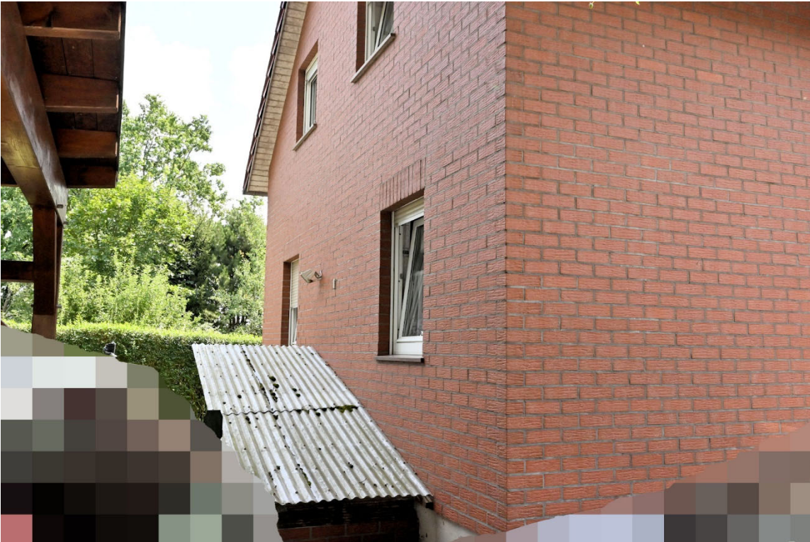
Abb. 11: Am Mokkaberg 3, nördlicher Giebel, Überdachung Kelleraußentreppe
