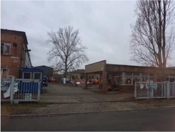
Gebäude 4 (abbruchreif) /Zufahrt Ansicht Rosenowstraße
