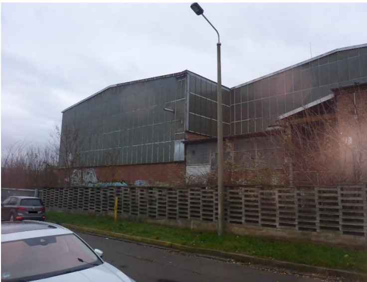
Gebäude 1, Halle 3 Ansicht Rosenowstraße
