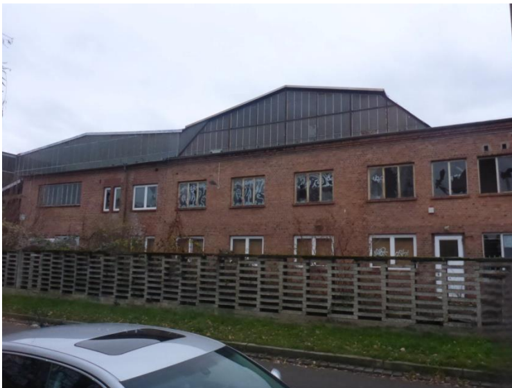
Gebäude 1, Halle 1 mit Bürotrakt Ansicht Rosenowstraße
