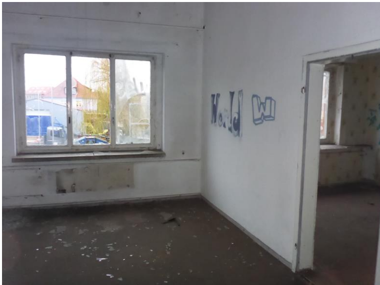
Gebäude 1, Halle 1 Bürotrakt
