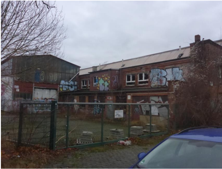
Gebäude 1 Halle 4 und Gebäude 2 Ansicht Dortmunder Straße
