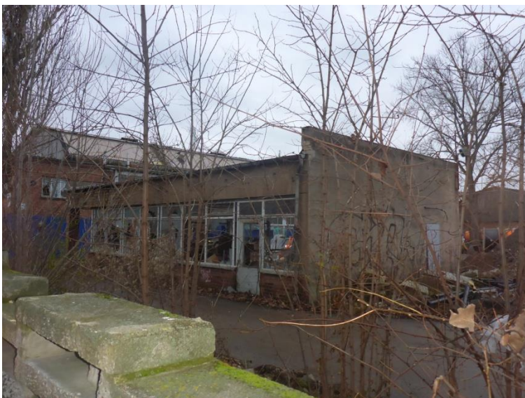
Gebäude 4 (abbruchreifes ehe- maliges Pförtnergebäude) - An- sicht Rosenowstraße
