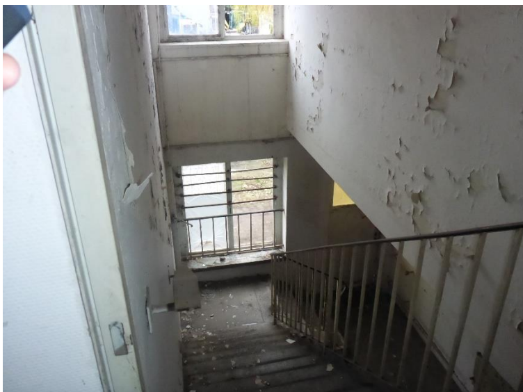
Gebäude 1, Halle 1 Bürotrakt
