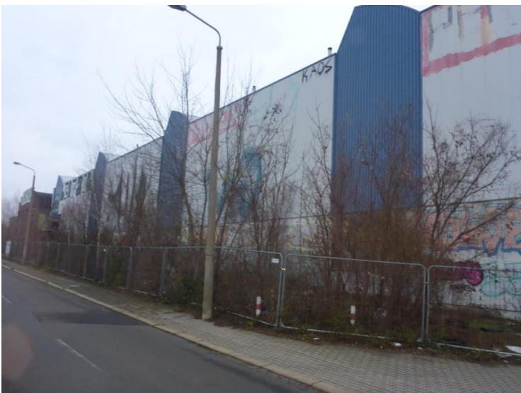
Gebäude 1, Halle 4 Ansicht Dortmunder Straße
