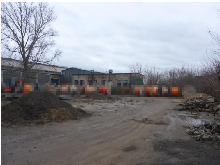
Außenlagerfläche Ansicht Rosenowstraße
