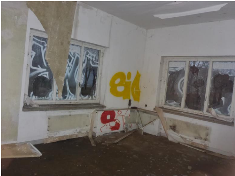
Gebäude 1, Halle 1 Bürotrakt
