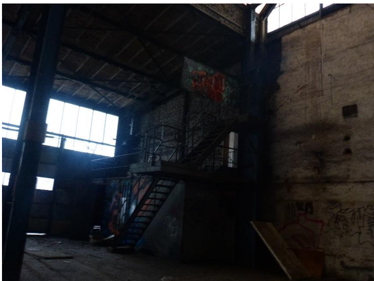
Gebäude 1, Halle 1 Bürotrakt
