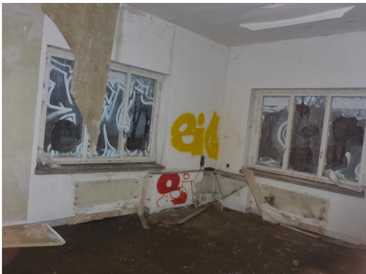
Gebäude 1, Halle 1 Bürotrakt
