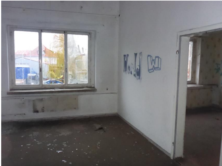
Gebäude 1, Halle 1 Bürotrakt
