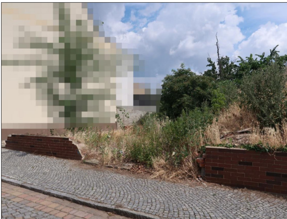
Bild 2: Straßenansicht Mühlberger Str. 9 (Flst. 202) mit nach dem Abbruch verbliebenen Gebäuderesten
