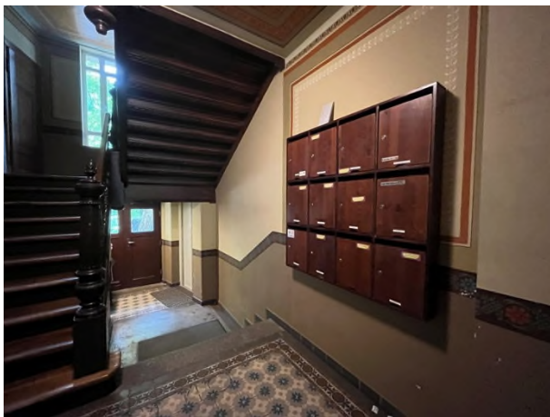
Treppe zum 1.OG
