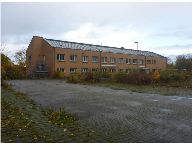
Ansicht von Südosten
