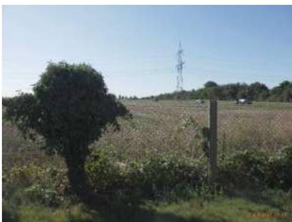
Blick nach Süden zur Luckaer Straße Umspannwerk
