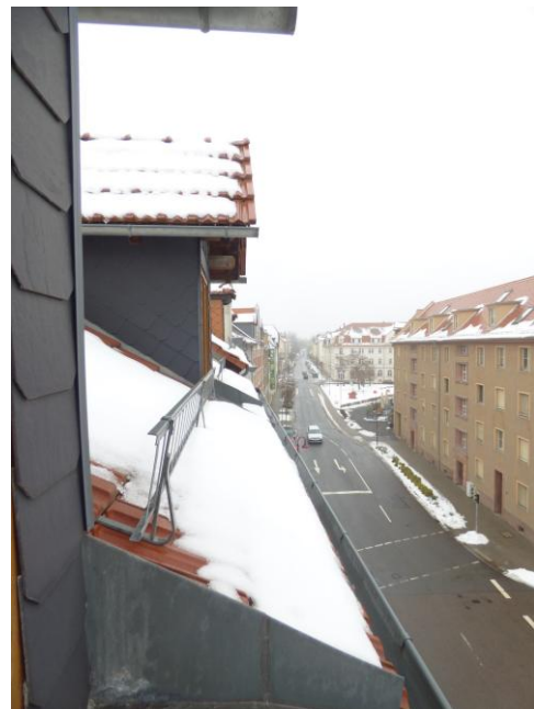
Bild 36: Blick auf die Dachfläche
