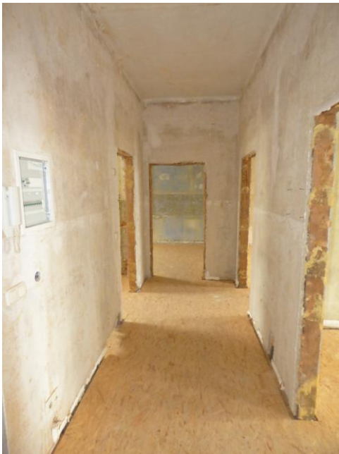
Bild 27: Zustand Wohnung im 1. Obergeschoss
