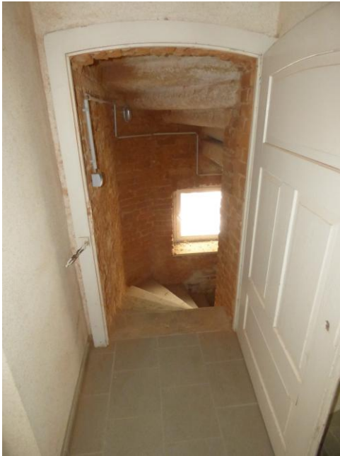
Bild 17: Zugang zum Keller
