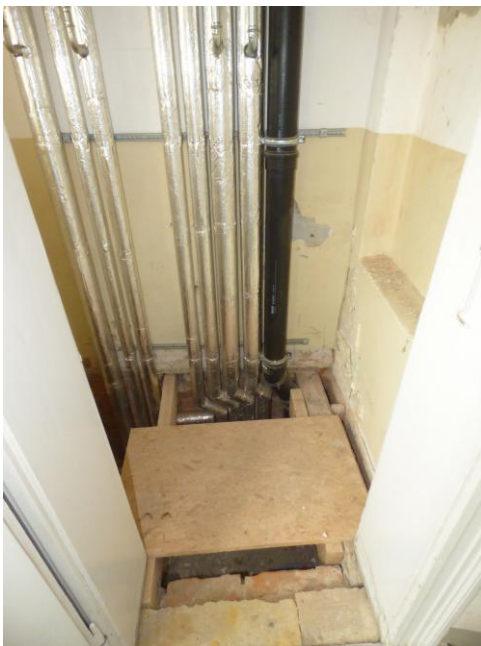
Bild 23: neue Steigstränge und Fallleitungen in ehemaligen Außen-WCs
