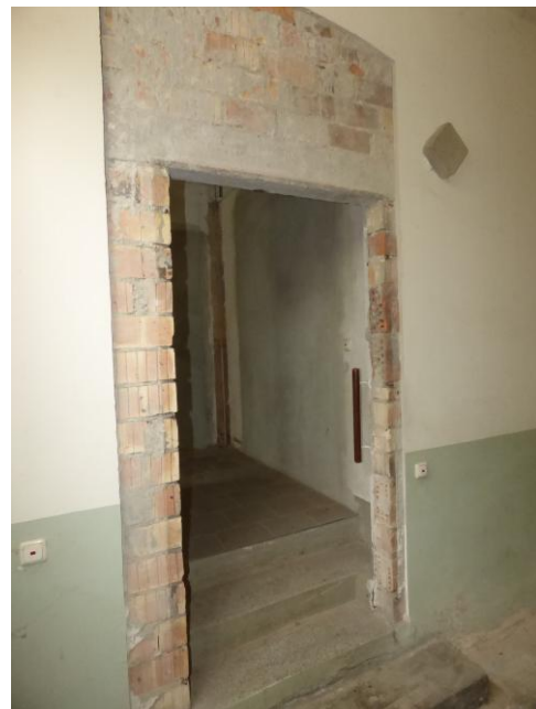
Bild 16: Zugang zum Treppenhaus
