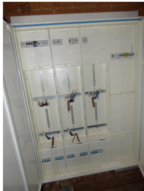
Bild 20: unfertiger Verteilerkasten
