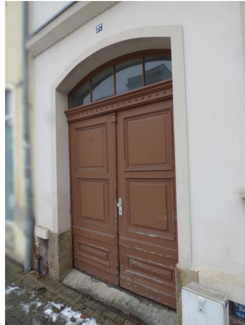
Bild 6: Eingangstor zum Treppenhaus
