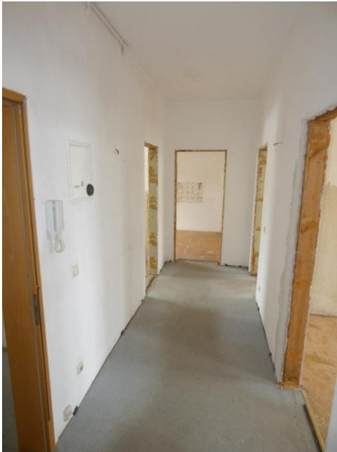
Bild 29: Zustand Wohnung im 2. Obergeschoss
