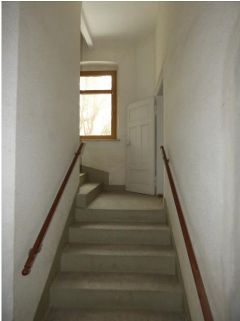
Bild 21: Treppenhaus im Erdgeschoss
