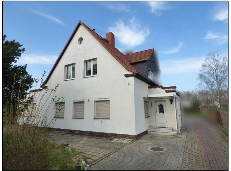
Abbildung 3 - Außenansicht des Gebäudes
