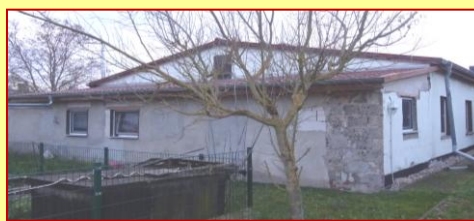
Hinteransicht des Wohnhauses
