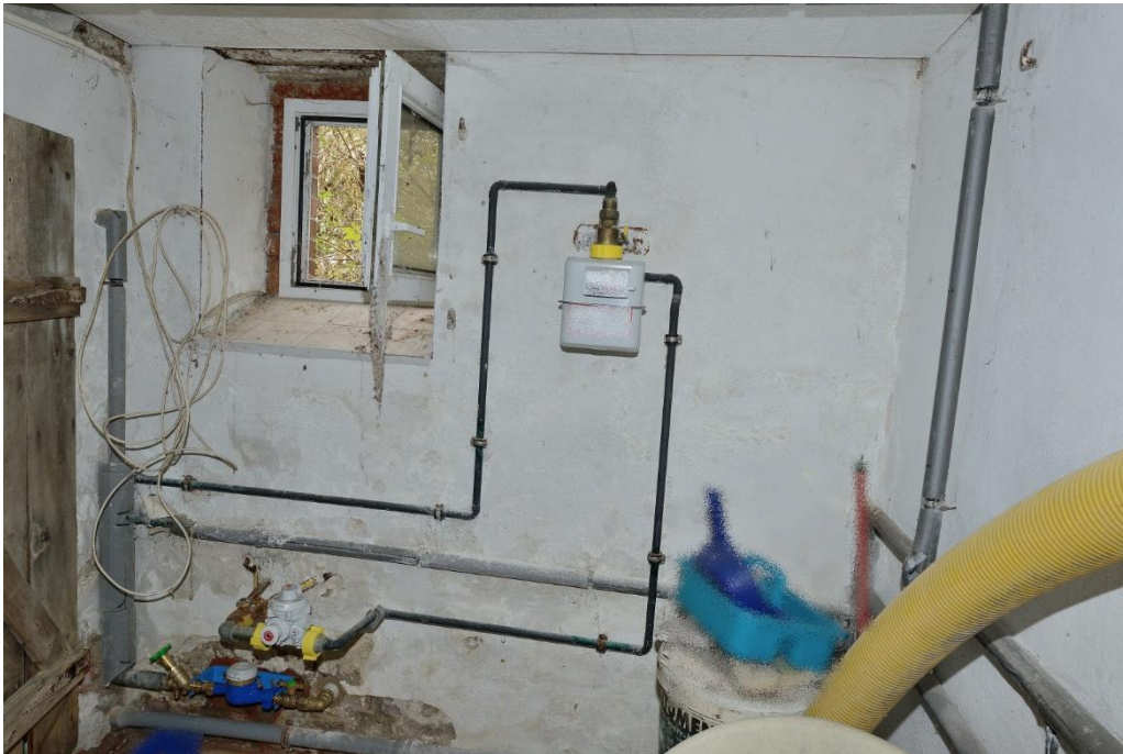
Innenansichten Wohnhaus / Keller Hausanschlüsse
