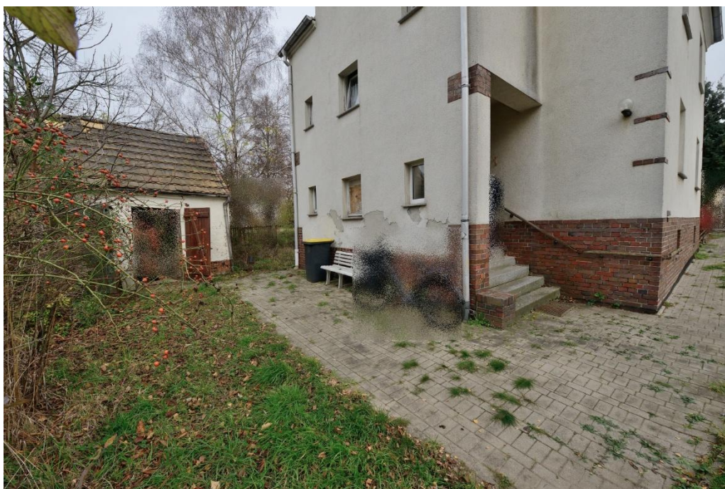
Hauseingang und Schuppen
