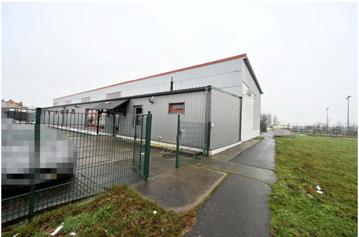
Abb. 6: Gebäudeansicht von der öffentlichen Verkehrsfläche "Am Sportplatz", Blickrichtung Nordosten
