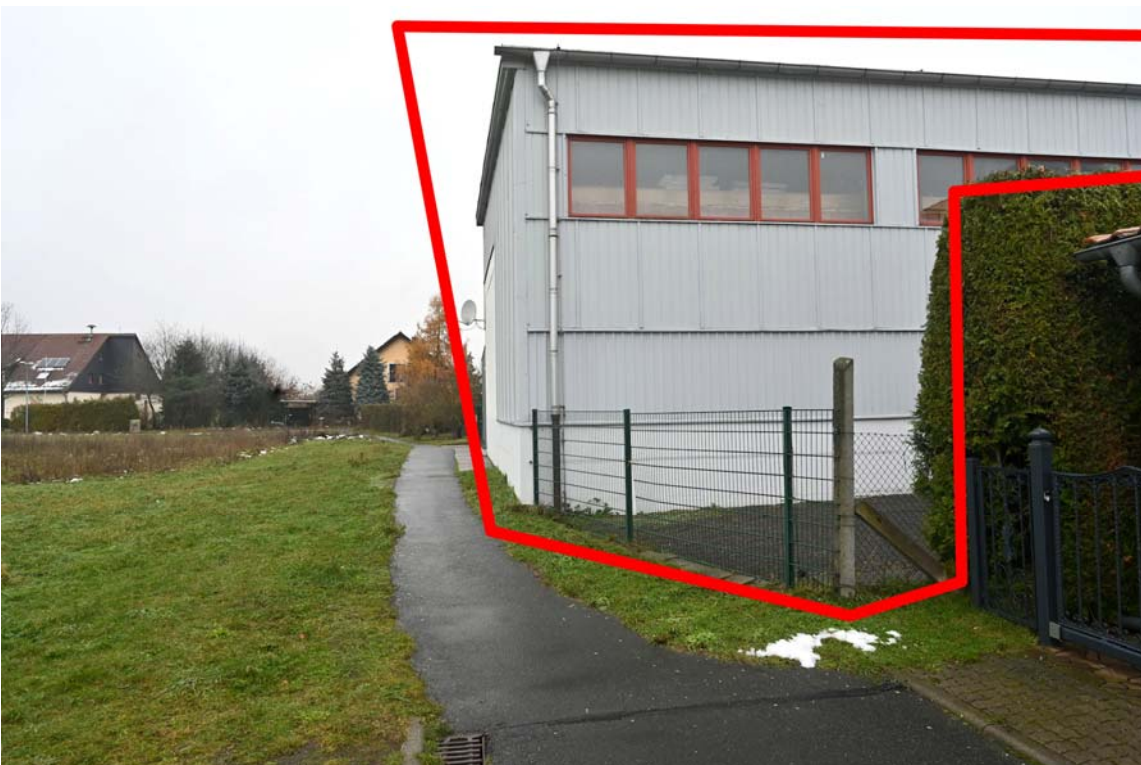
Abb. 8: Gebäudeansicht von der öffentlichen Verkehrsfläche "Am Sportplatz", Blickrichtung Westen, Kennzeichnung Bewertungsobjekt
