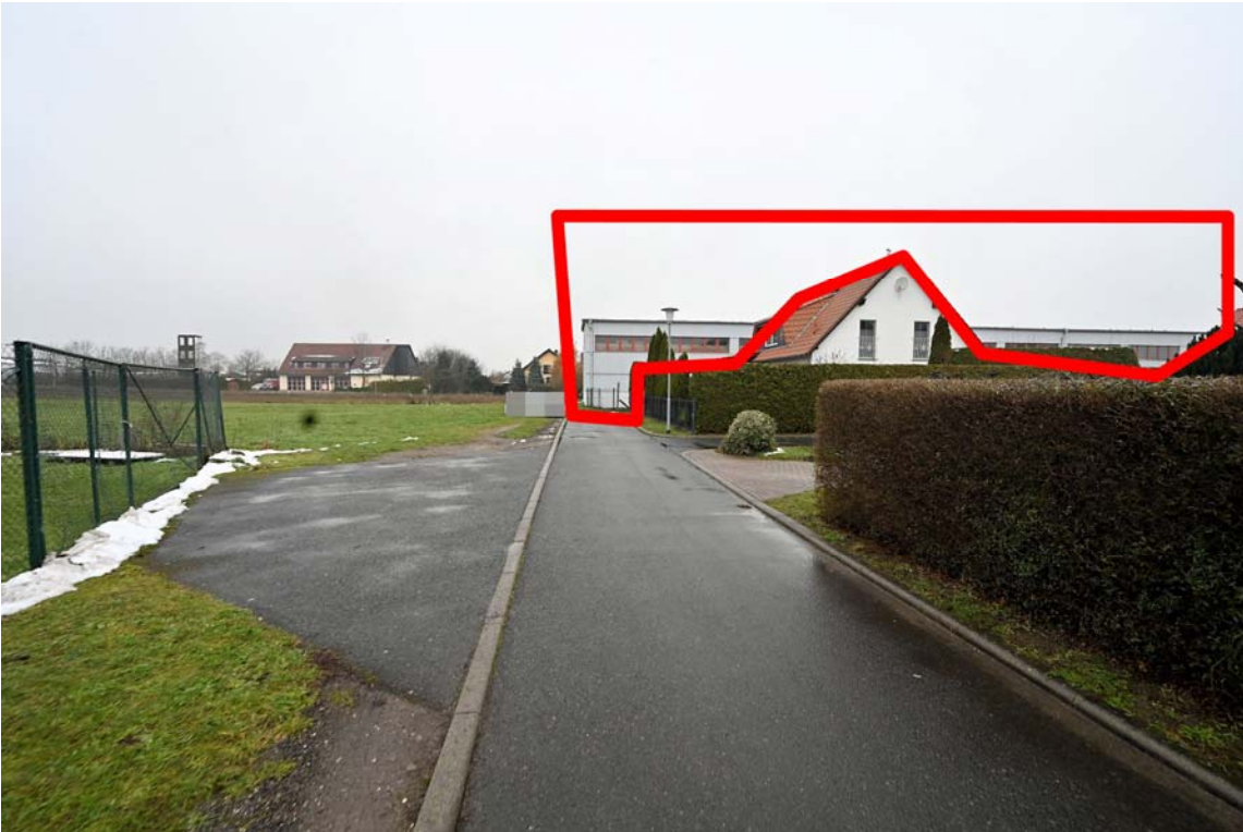
Abb. 7: Grundstücksansicht von der öffentlichen Verkehrsfläche "Am Sportplatz", Blickrichtung Westen, Kennzeichnung Bewertungsobjekt
