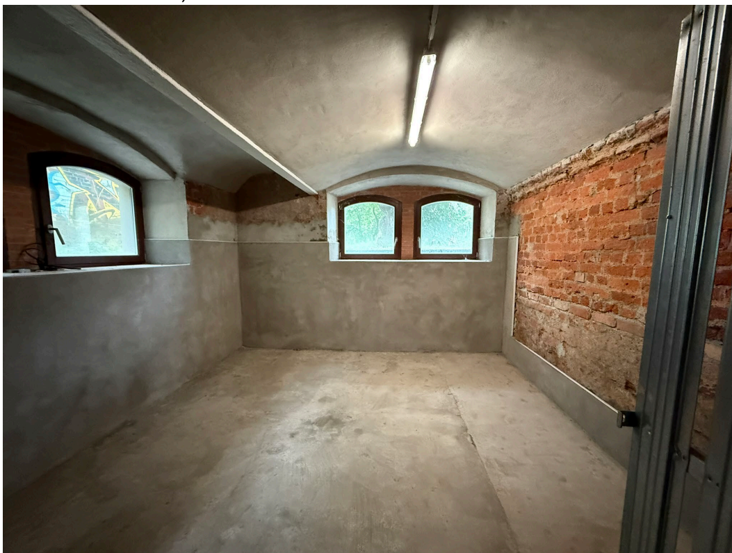
Lageraum Nr. 5 im Kellergeschoss
