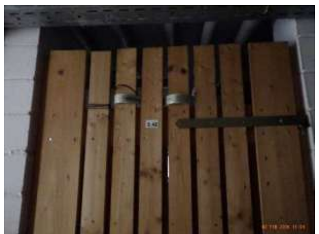
Tür zum Kellerraum 2.42
