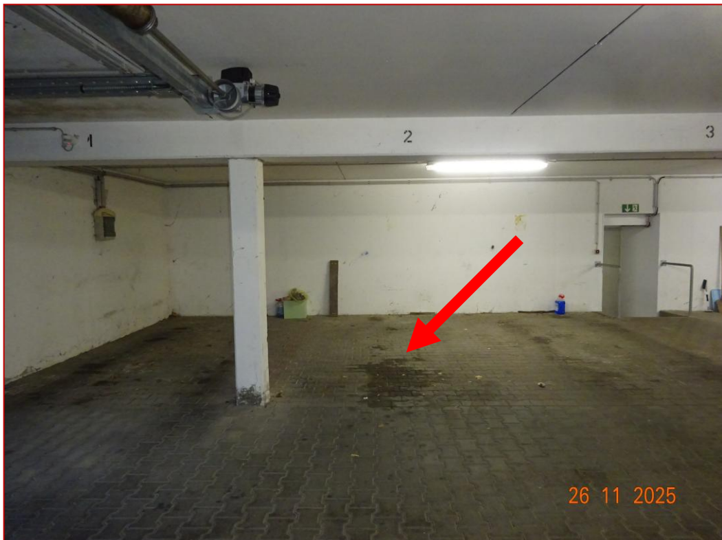
Blick auf den Tiefgaragenstellplatz TG 2 im Objekt – Alte Salzstraße 4 in Taucha OT Merkwitz –
