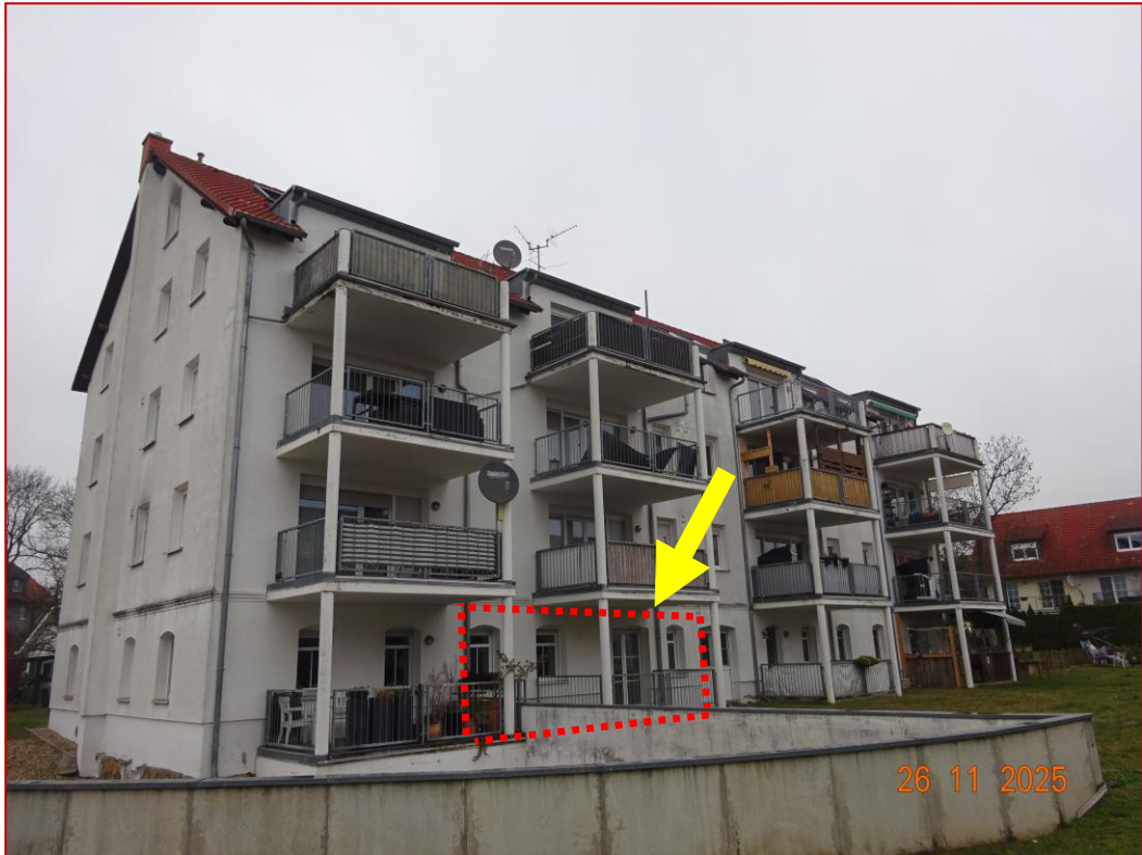
Ansicht der Eigentumsanlage und Lage der ETW Nr. 2 im Objekt – Alte Salzstraße 4 in Taucha OT Merkwitz –
