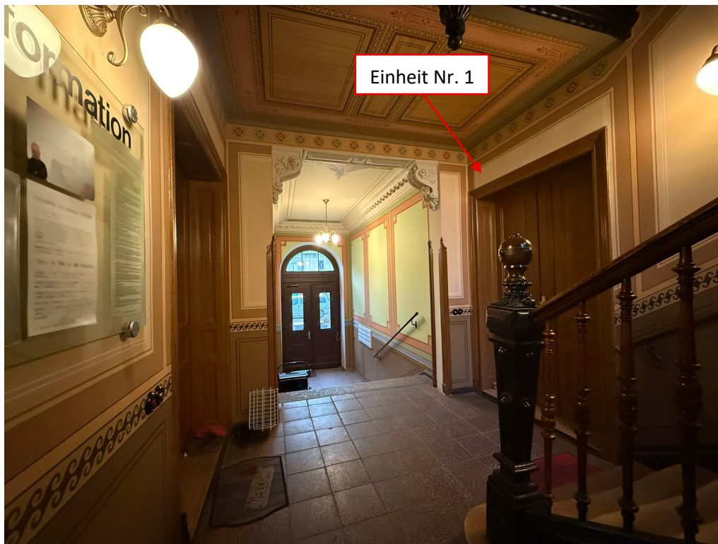
Treppenhaus im Erdgeschoss
