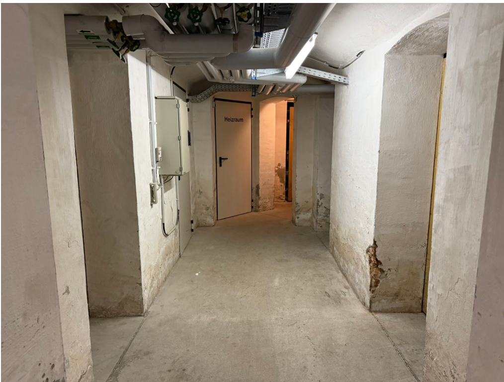
Kellergang im Kellergeschoss (Gemeinschaftseigentum)
