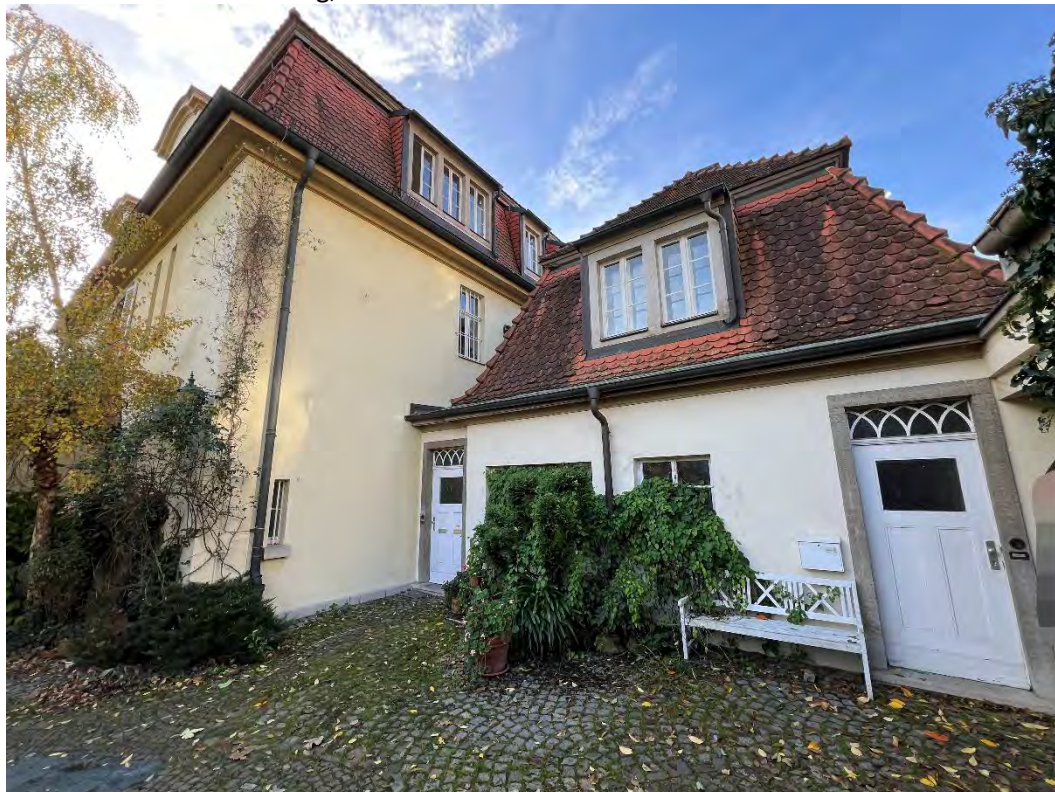
Blick aus östlicher Richtung - links: Villa, rechts: Anbau (ehem. Wirtschaftsbereich der Villa)
