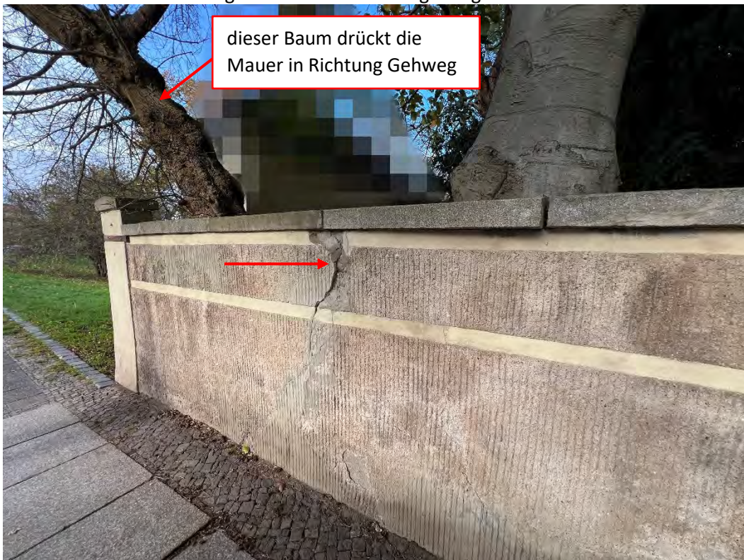
Schäden an der Einfriedungsmauer am Poetenweg infolge Drucks durch Baumstamm
