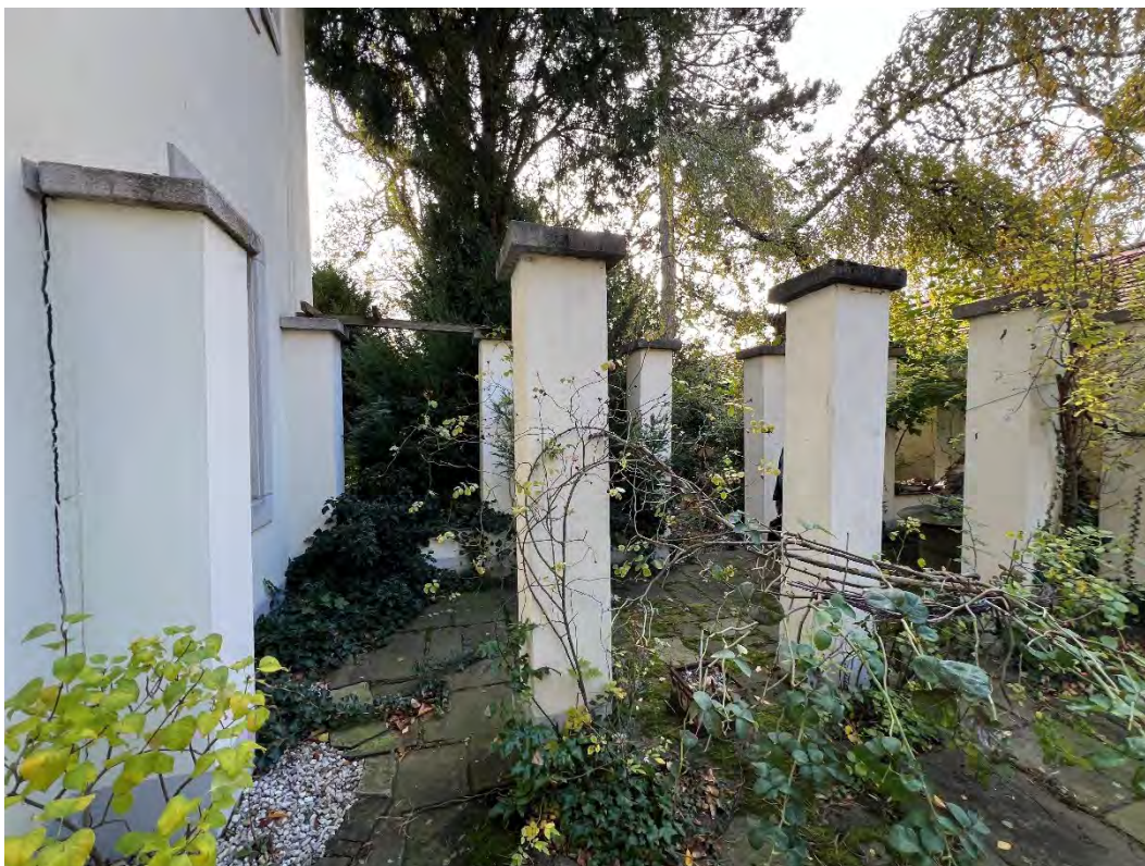
Brunnenhof westlich der Villa; früher mit Pergola-Überdachung
