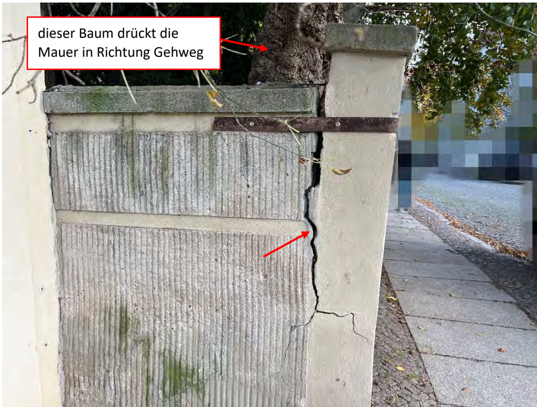
Schäden an der Einfriedungsmauer am Poetenweg infolge Drucks durch Baumstamm
