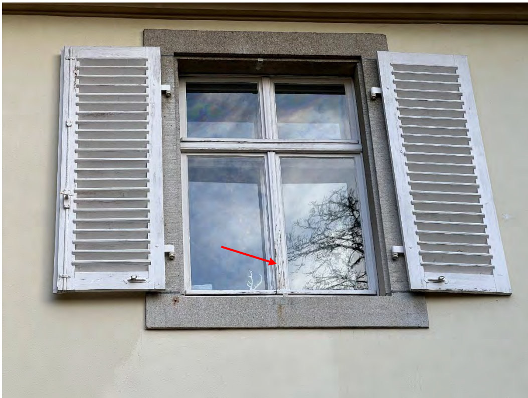
erforderlicher Holzschutz; hier: Fensteraußenseiten
