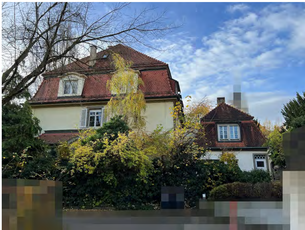
Blick aus östlicher Richtung; rechts im Bild der Anbau mit der ehem. Hausmeisterwohnung im DG
