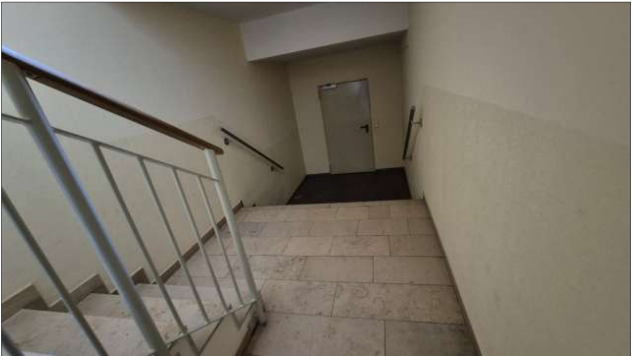
Foto 12: Zugang zum Kellergeschoss
