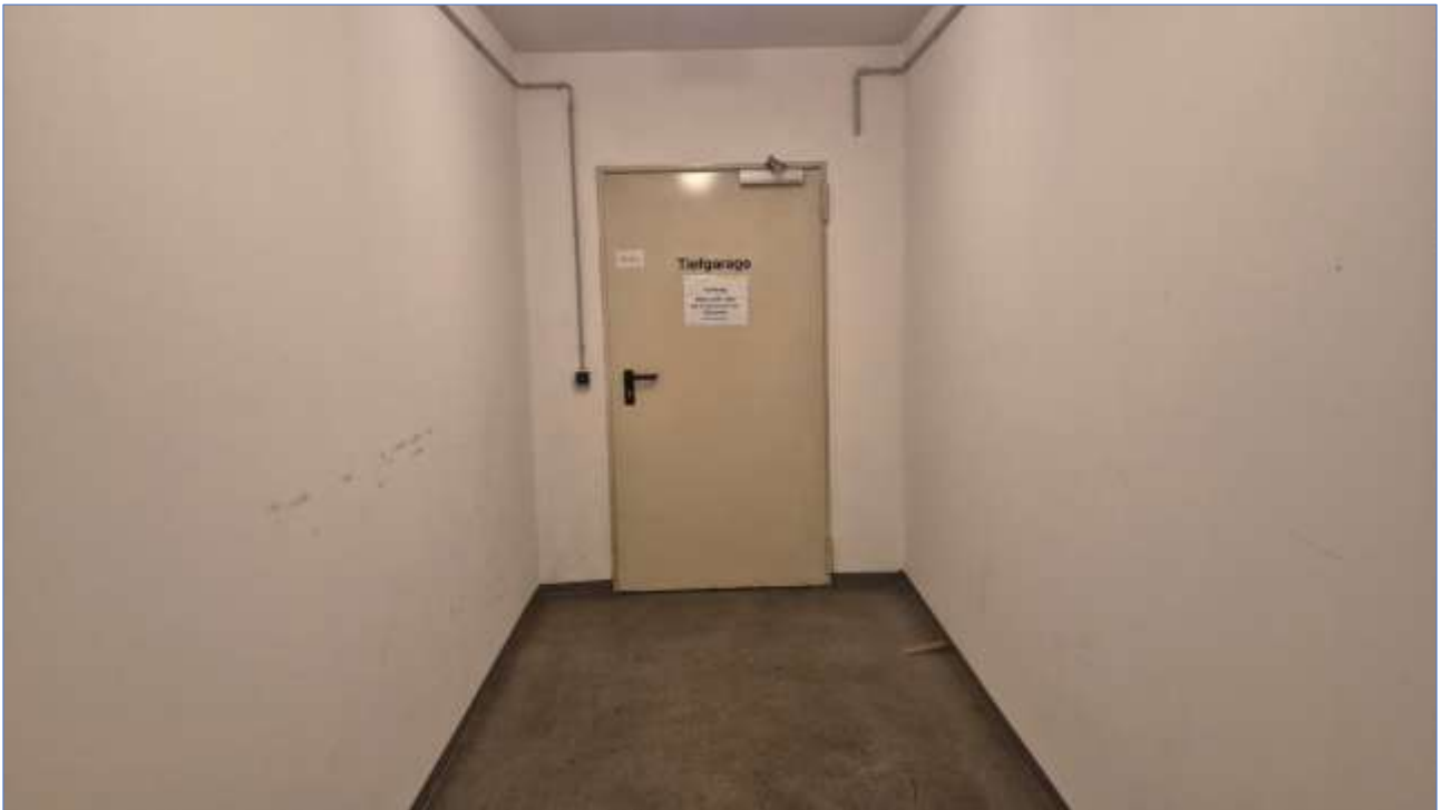
Foto 7: Schleuse zur Tiefgarage
