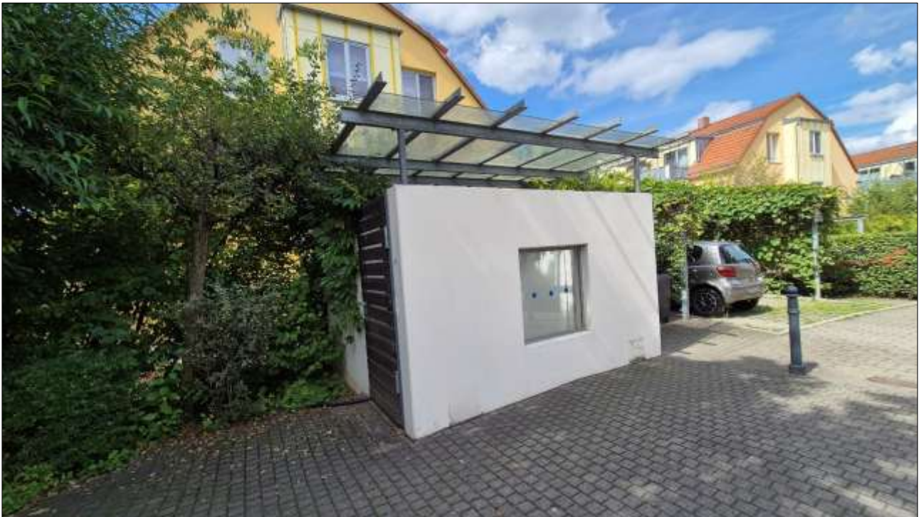
FOTO 3: separater Zugang zur Tiefgarage
