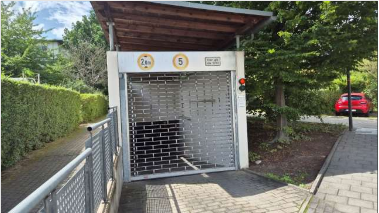
Foto 5: Zufahrt zur Tiefgarage
