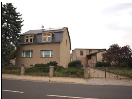
straßenseitige Ansicht aus Richtung Süden
