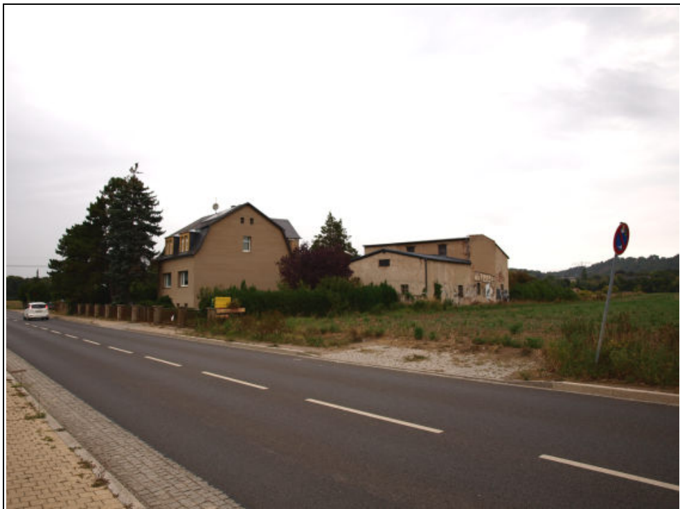
Abbildung 15: straßenseitige Ansicht des ZFH und der Nebengebäude aus Richtung Osten, Lage im Außenbereich nach § 35 BauGB
