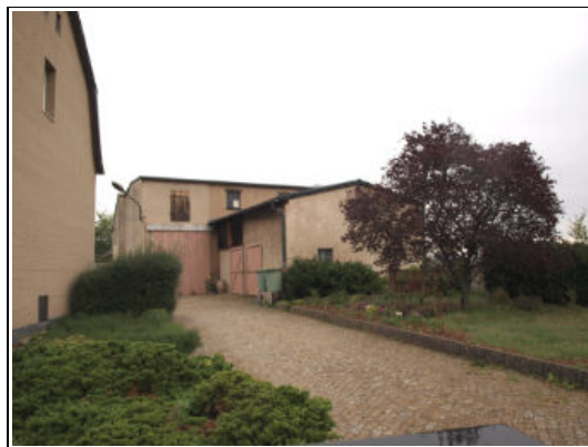
straßenseitige Ansicht der Nebengebäude
