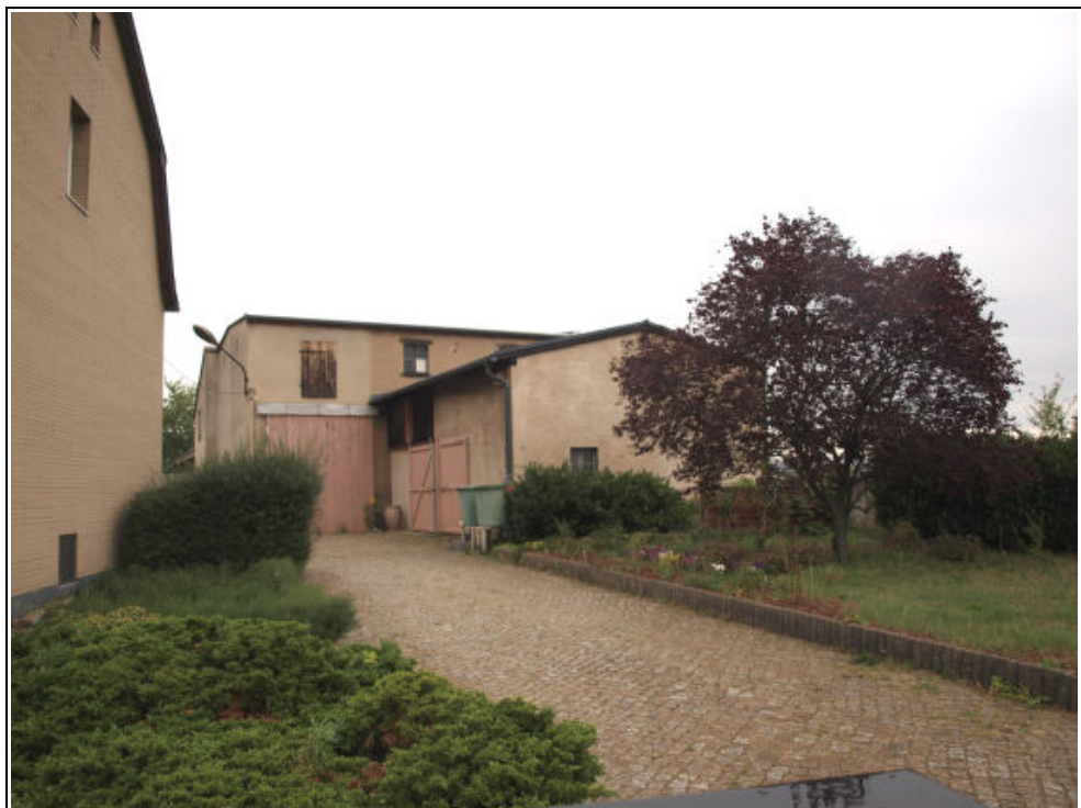
Abbildung 11: straßenseitige Ansicht der Nebengebäude aus Richtung Süden
