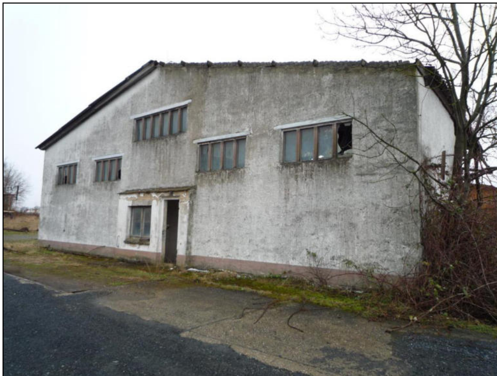
Bild 1: Straßenansicht des ehem. Werkstattgebäudes mit Unterstellhalle
