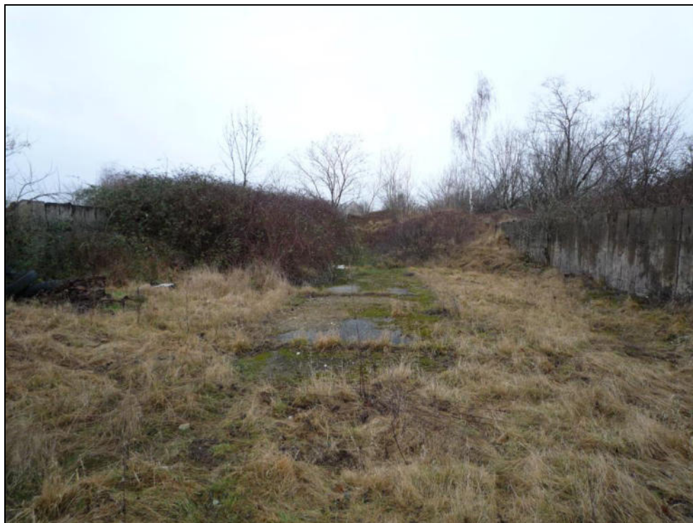
Bild 15: Blick von Osten in die Siloanlage
