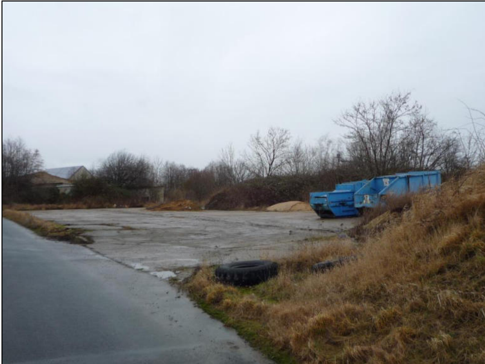
Bild 19: befestigte Freifläche an der Großdobritzer Straße südlich der Siloanlage
