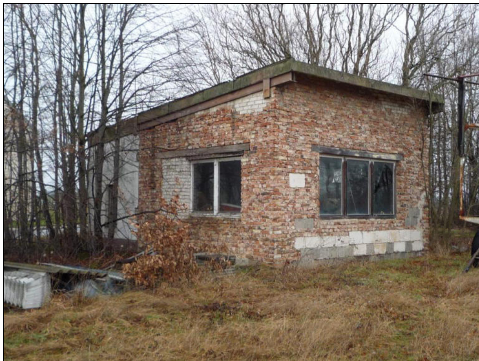
Bild 11: ehem. Bürogebäude am Standort der Tankstelle
