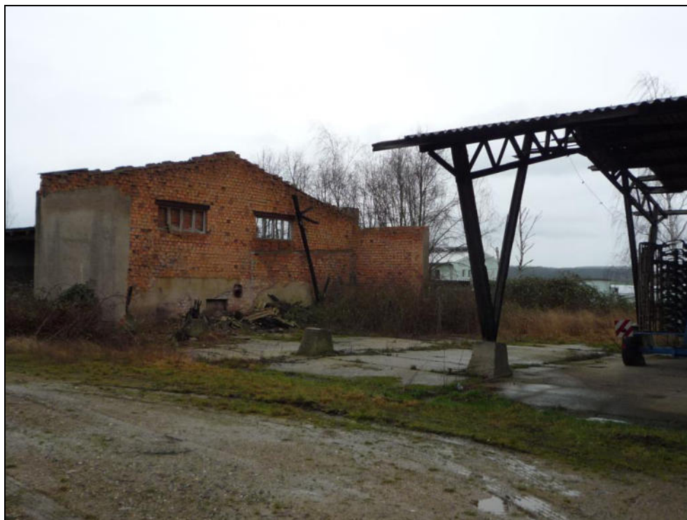
Bild 3: Nordansicht des ehem. Werkstattgebäudes mit Unterstellhalle
