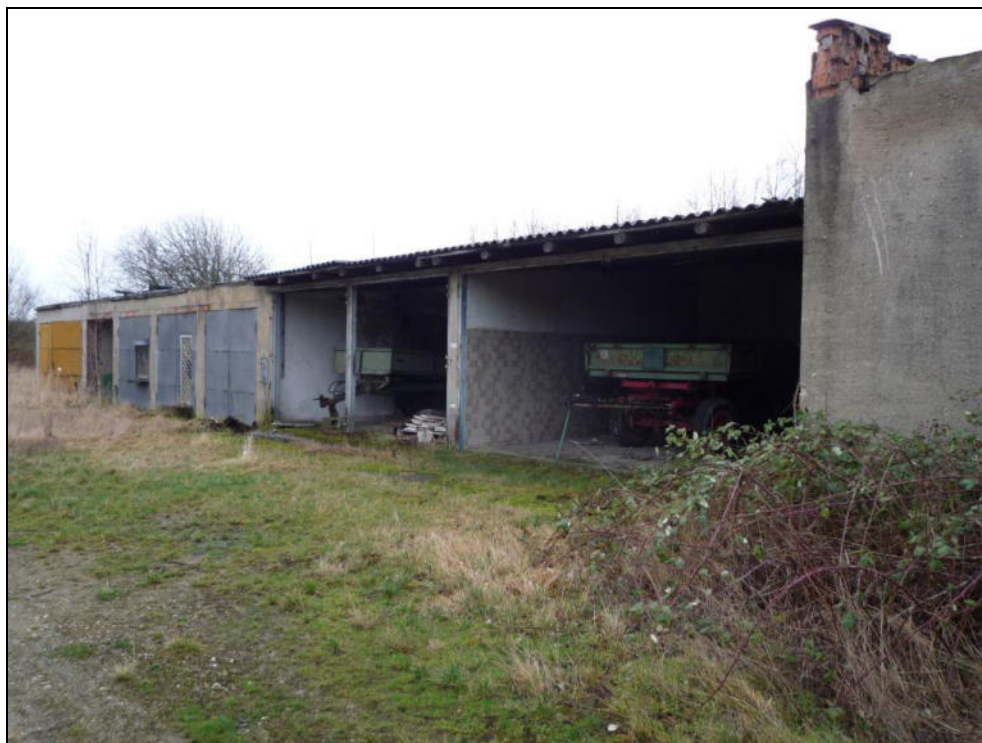
Bild 5: Nordansicht der nördlichen Reihe Lagerboxen am ehem. Werkstattgebäude
