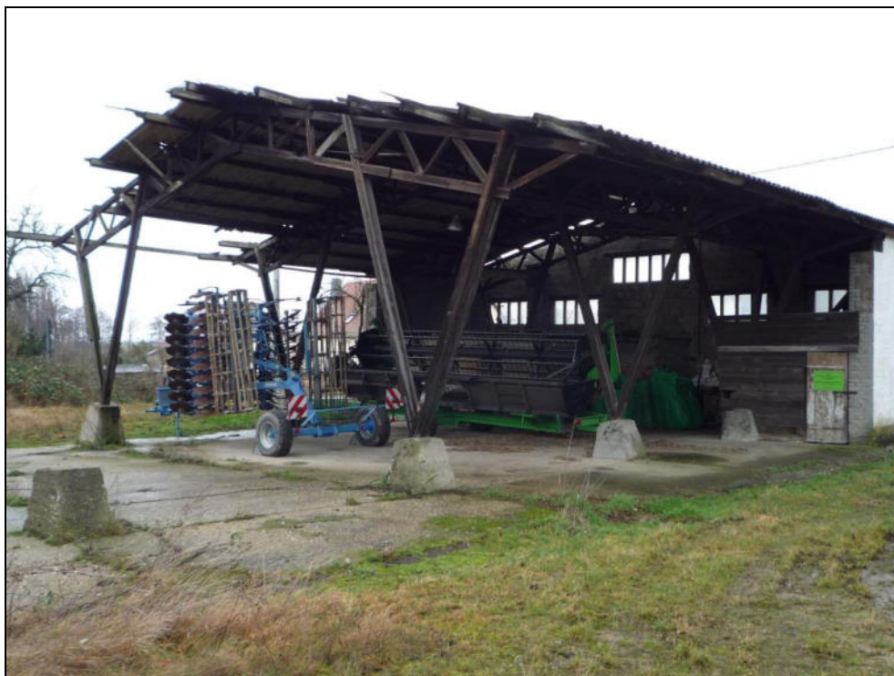
Bild 2: Nordansicht des ehem. Werkstattgebäudes mit Unterstellhalle
