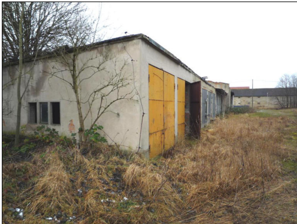
Bild 9: Ostansicht der nördlichen Reihe Lagerboxen
