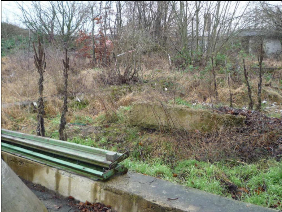
Bild 25: alte Grundmauern zwischen nördlicher Freifläche und ehem. Werkstattgebäude
