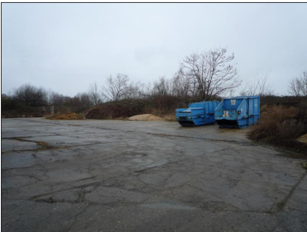
Bild 20: befestigte Freifläche an der Großdobritzer Straße südlich der Siloanlage
