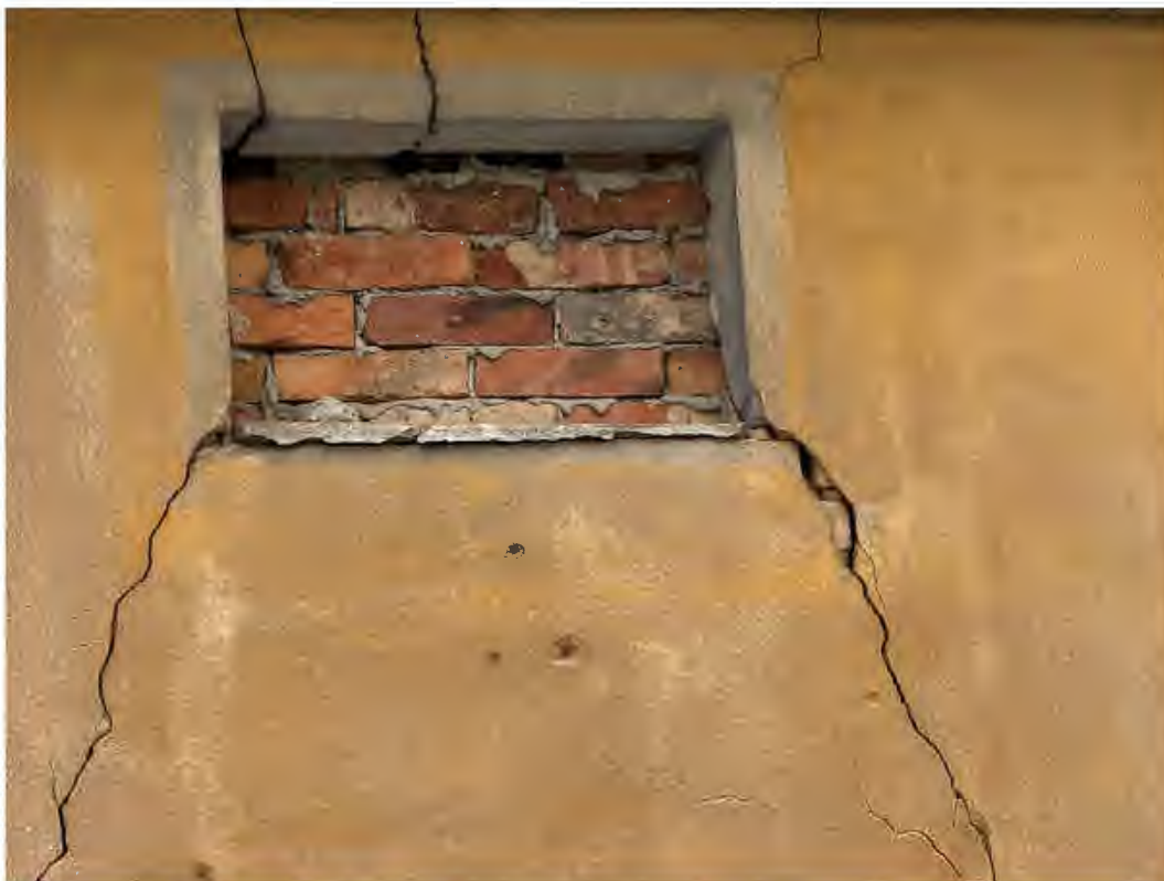
früheres Wohnhaus – Fassadenrisse fast überall
