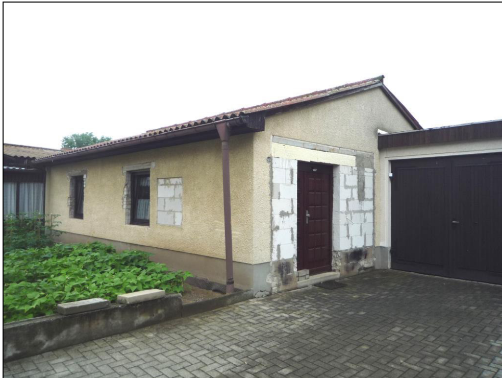
Bild 3: Hofansicht des Wohngebäudes
