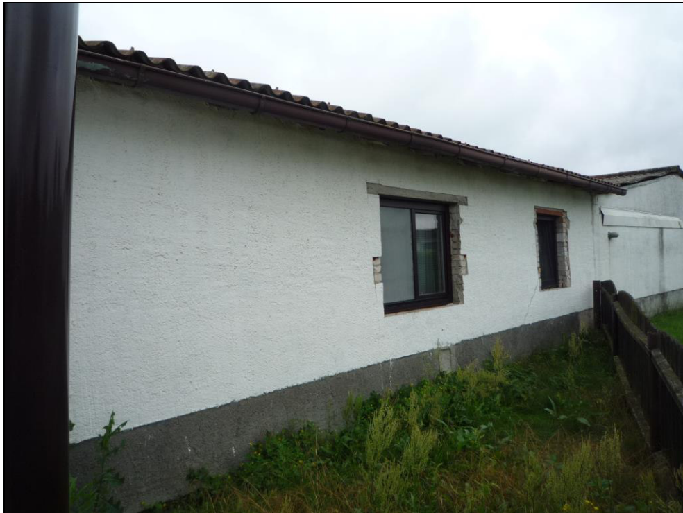
Bild 5: Rückansicht des Wohngebäudes
