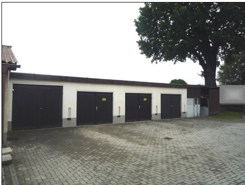
Bild 2: Hofansicht des Garagengebäudes mit Schuppenanbau
