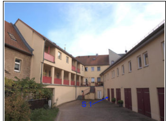
hofseitige Ansicht des Wohn- und Geschäftshauses mit dem Sondereigentum Nr. S 1 im Nebengebäude gelegen
