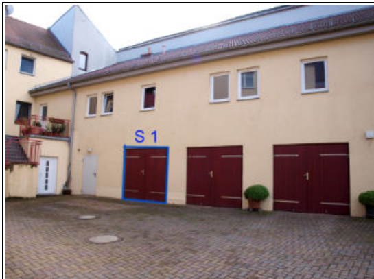
hofseitige Ansicht mit SE-Nr. S 1, Grundstück weiter bebaut mit einem WGH
