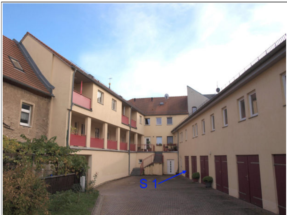
Abbildung 10: hofseitige Ansicht des Wohn- und Geschäftshauses mit dem Sondereigentum Nr. S 1 im Nebengebäude gelegen
