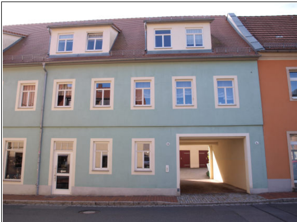
Abbildung 8: straßenseitige Ansicht Meißner Straße, Durchfahrt zum Innenhof
