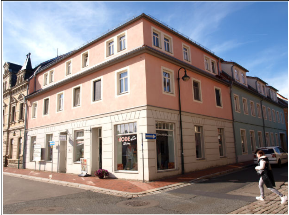
Abbildung 9: Wohn- und Geschäftshaus am Markt 16 (Eckgebäude) aus Richtung Südost
