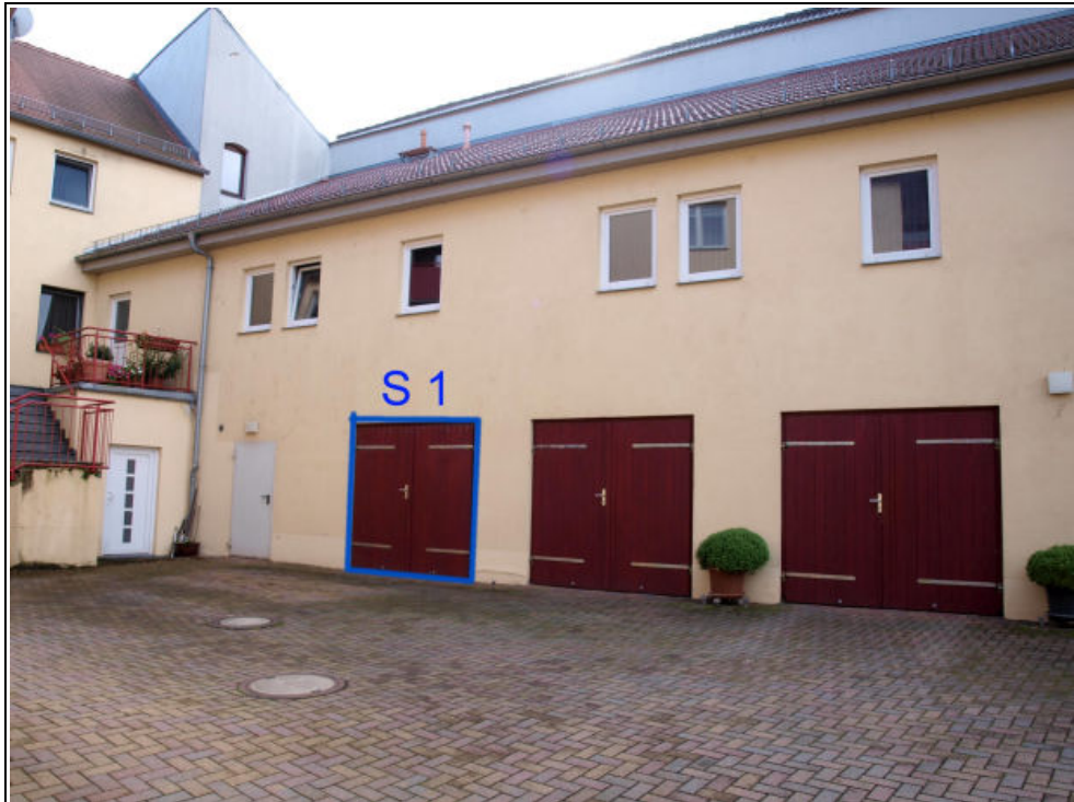
Abbildung 7: hofseitige Ansicht mit SE-Nr. S 1, Grundstück weiter bebaut mit einem WGH
