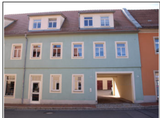
straßenseitige Ansicht Meißner Straße, Durchfahrt zum Innenhof
