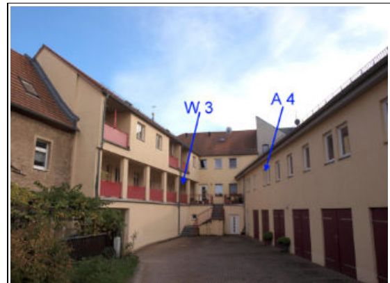
hofseitige Ansicht mit SE-Nr. W 3 im 1.OG/2.OG und Abstellraum A4
