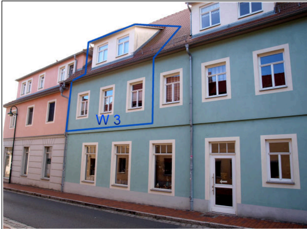
Abbildung 9: straßenseitige Ansicht mit SE-Nr. W 3 im 1.OG/DG aus Norden
