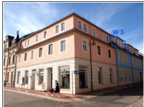
WG (Eckgebäude) aus Richtung Südost, SE-Nr. W 3 im 1.OG/DG an Meißner Straße
