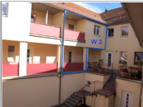
hofseitige Ansicht mit SE-Nr. W 3 im 1.OG/2.OG, Erschließung über Laubengang
