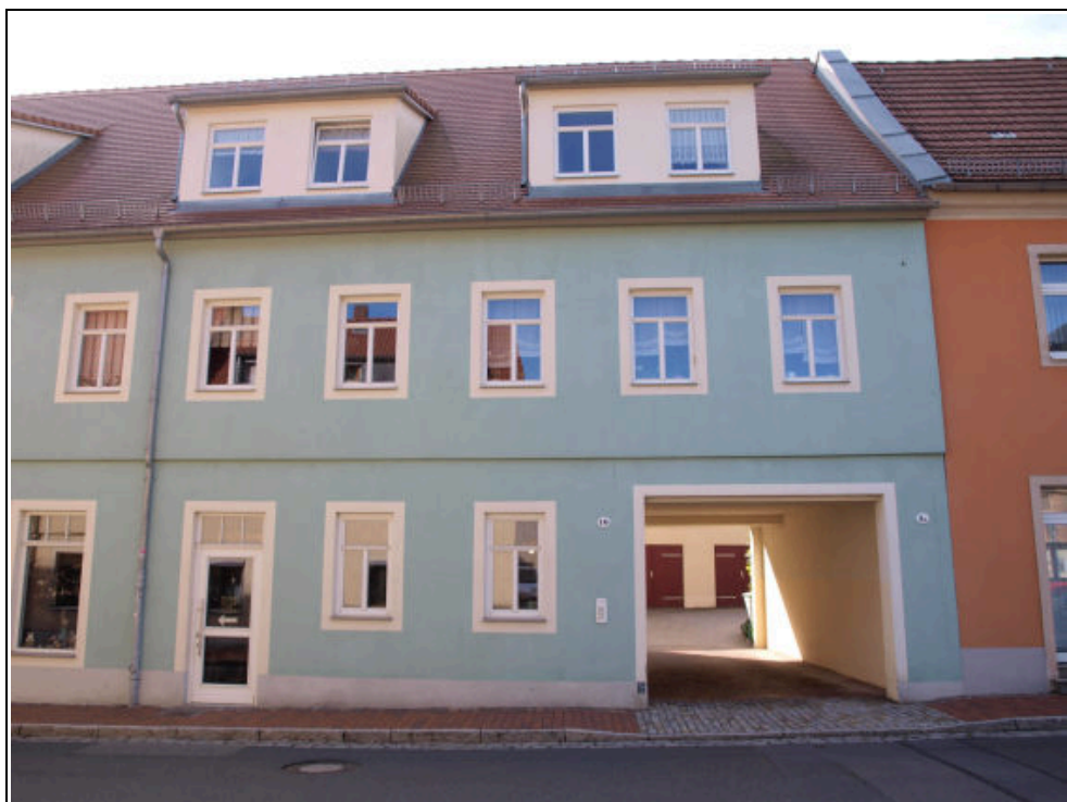
Abbildung 10: straßenseitige Ansicht von der Meißner Straße, Durchfahrt zum Innenhof und Zugang zu den Wohnungen
