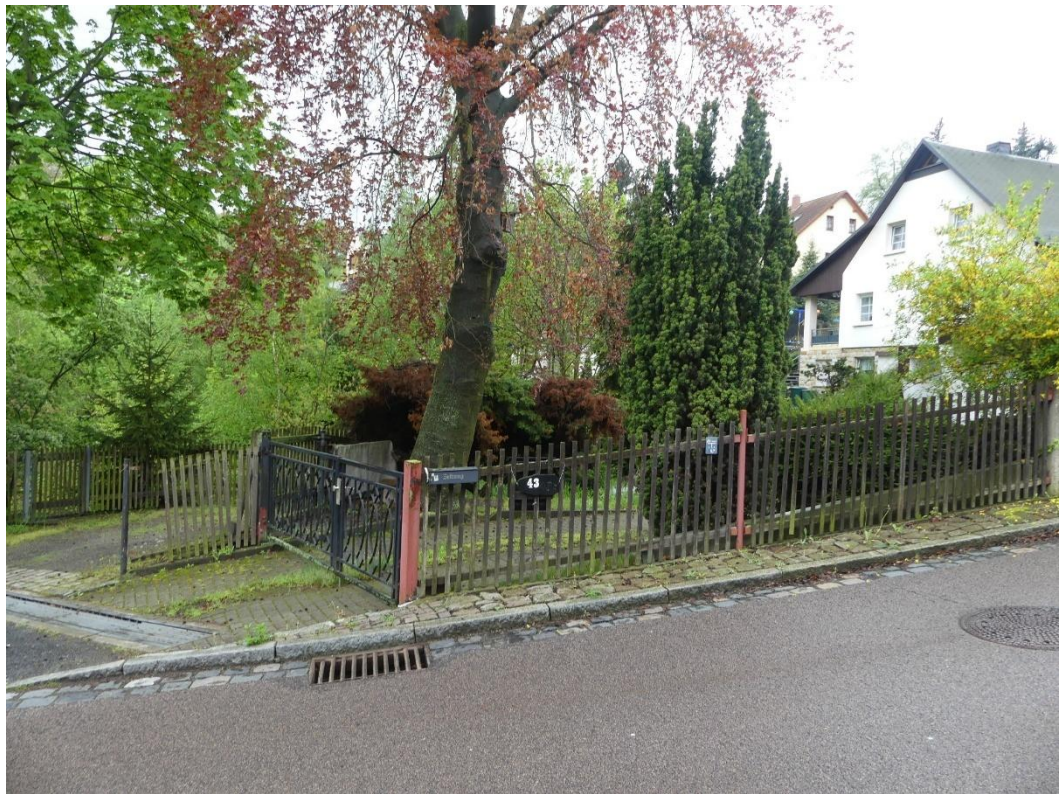
Foto 1: Straßenansicht mit Zufahrt
