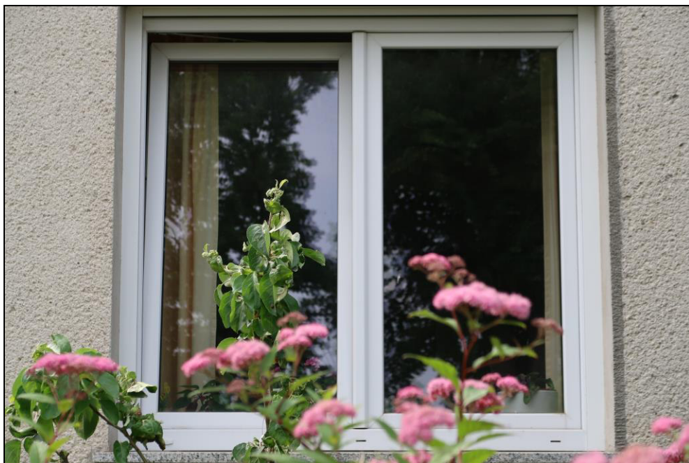
Bild 7: Wohngebäude, Detailansicht Kunststofffenster
