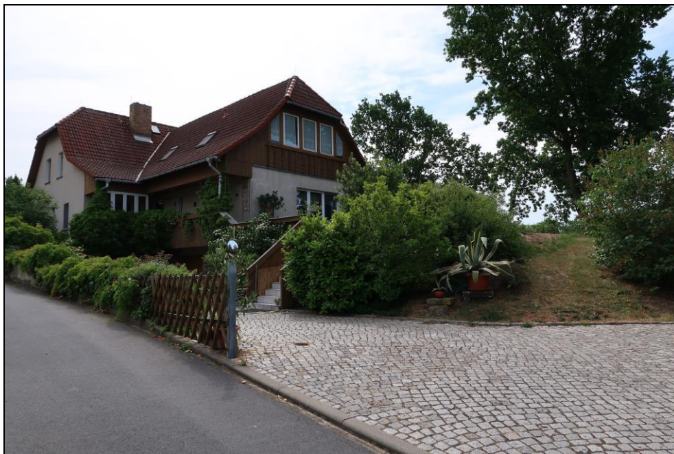
Bild 3: Straßenansicht mit Zufahrt (Flst. 408/10, Gem. Sacka)
