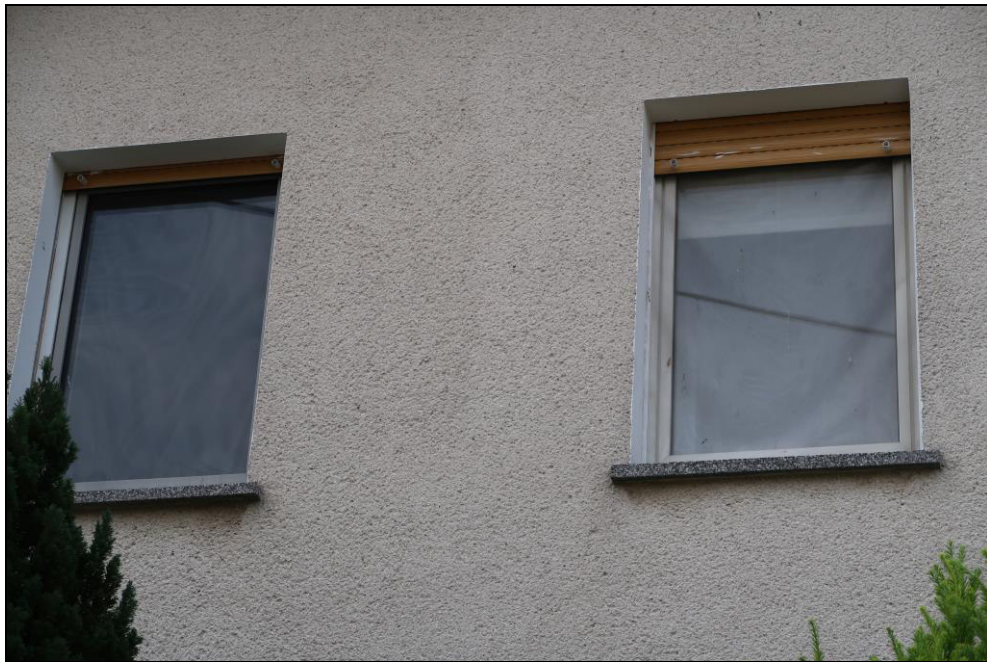
Bild 7: Wohngebäude, Detailansicht Kunststofffenster mit Holzjalousien aus Holz
