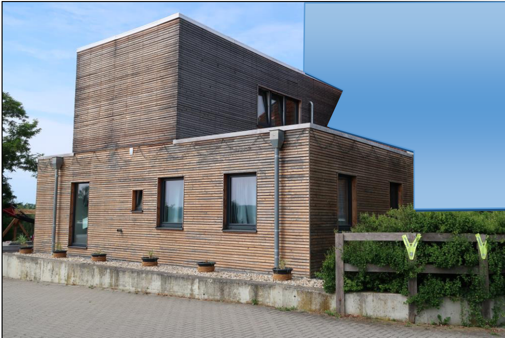
Bild 1: Neubau (Ost) am Wohnhausaltbau Radeburger Str. 20 b / Gebäudeteil teils auf Nachbargrundstück Flst. 408/10 der Gemarkung Sacka errichtet
