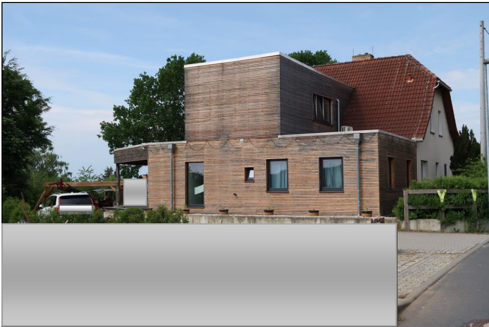
Bild 2: Neubau (Ost) am Wohnhausaltbau Radeburger Str. 20 b / Gebäudeteil teils auf Nachbargrundstück Flst. 408/10 der Gemarkung Sacka errichtet
