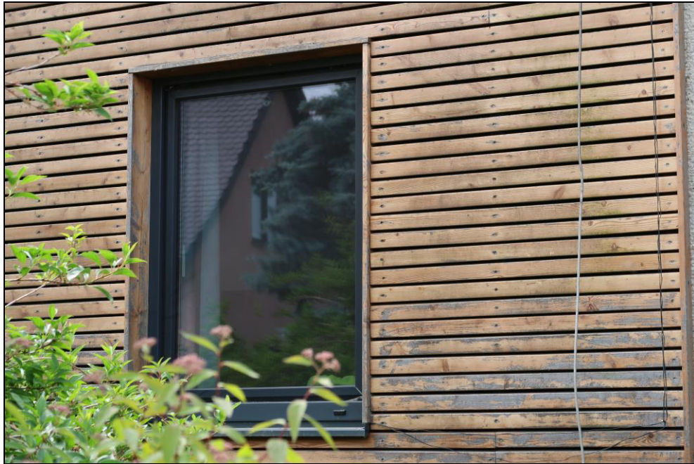
Bild 3: Detailansicht der Fassade Neubau (Ost)
