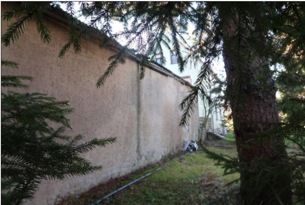
Bild 10: nordwestliche Rückfront des Nebengebäudes
