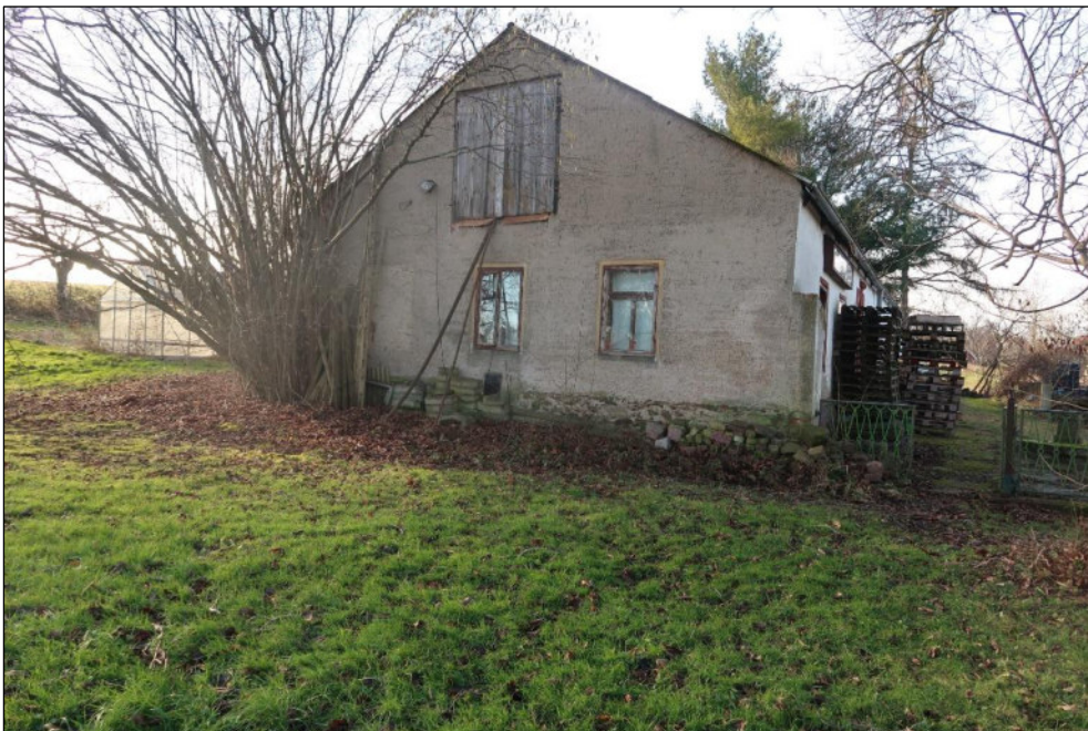
Bild 14: ehem. Wohn-/Stallgebäude als südliche Hofabgrenzung
