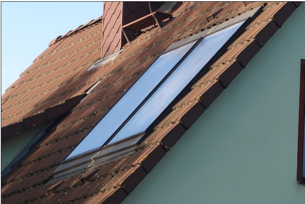
Bild 4: Detailansicht der Dacheindeckung des Wohngebäudes mit integrierten Solarmodulen
