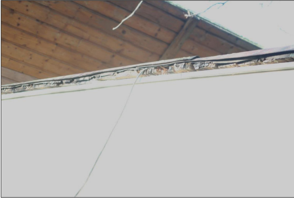
Bild 9: Nebengebäude, Detailansicht der Dacheindeckung des Anbaus am Nebengebäude (Holzschalung / Bitumen)
