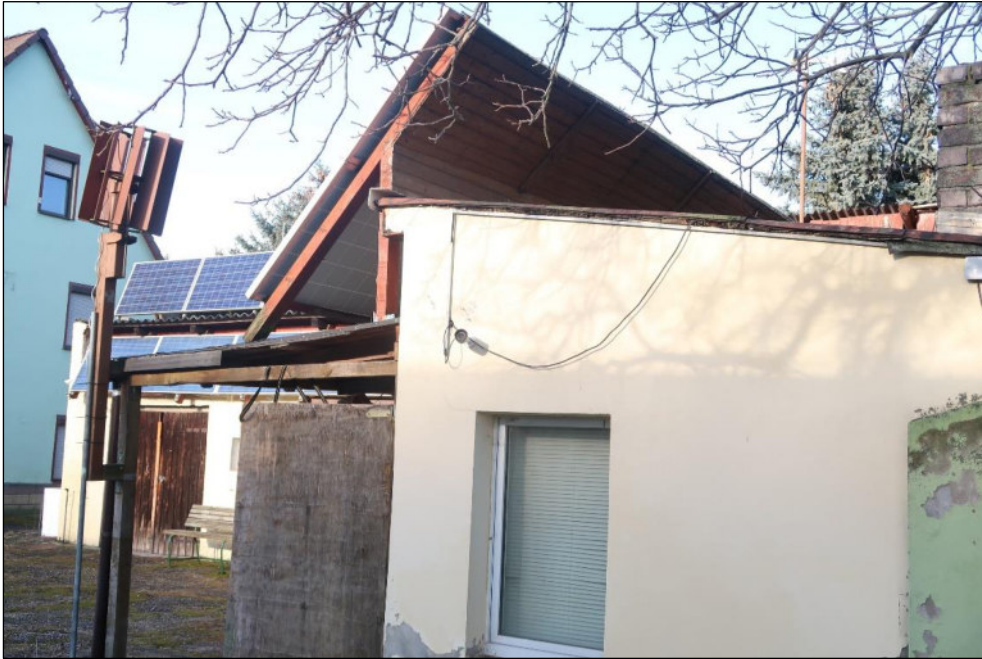
Bild 7: Nebengebäude / Anbau am Nebengebäude jeweils mit Photovoltaikanlage
