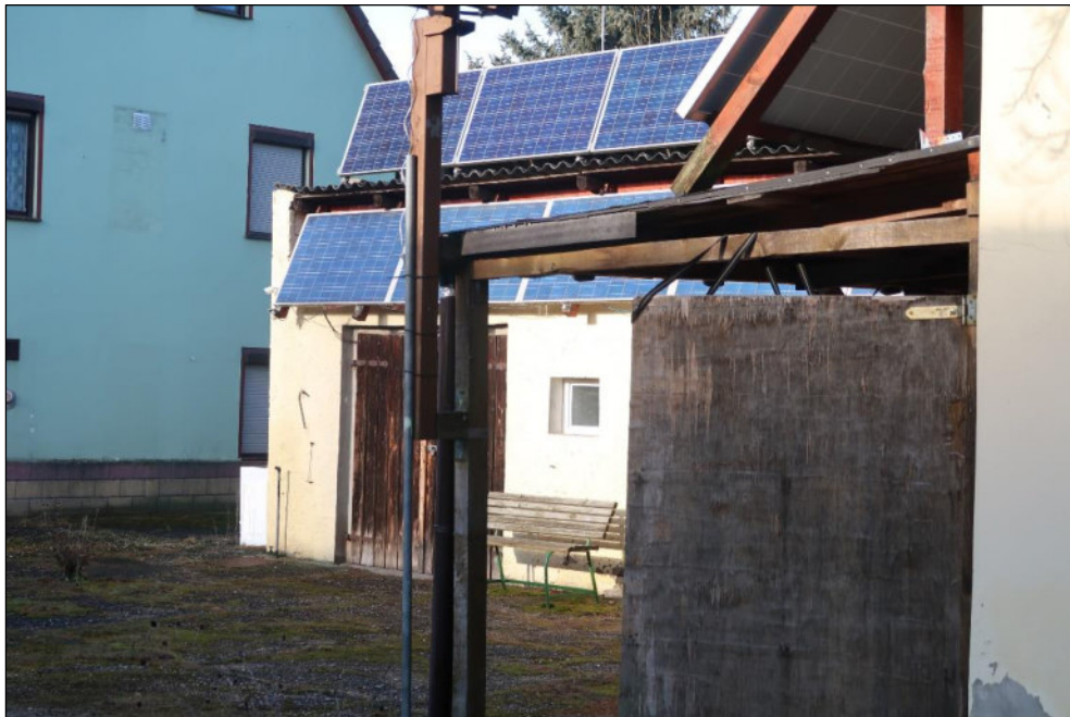
Bild 6: Nebengebäude mit Photovoltaikanlage zur Eigennutzung
