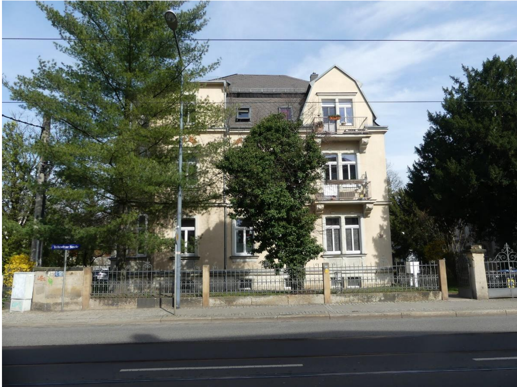
Foto 1: Straßenansicht Tolkewitzer Straße
