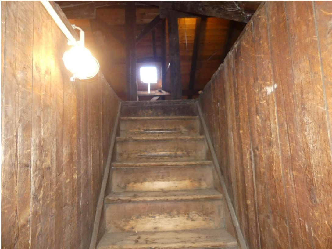
Foto 17: Zugang zum Dachboden
