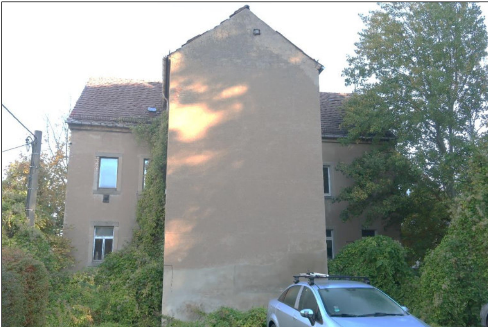
Bild 4: Gebäudeansicht vom Nachbargrundstück Flst. 61/4
