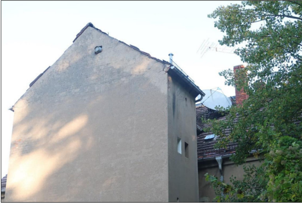
Bild 5: Gebäudeansicht vom Nachbargrundstück Flst. 61/4
