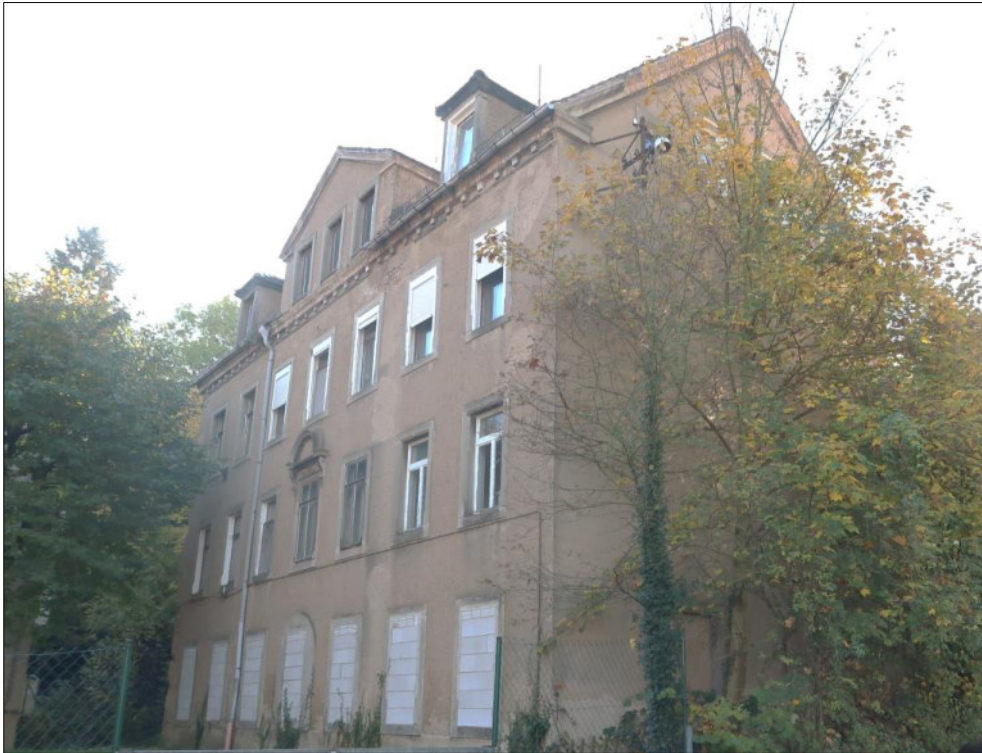
Bild 1: Straßenansicht Mehrfamilienhaus Drosselgrund 3
