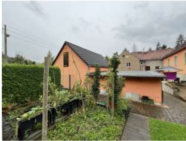
Foto 12: Ansicht aus Osten links Garage, rechts Hundezwinger
