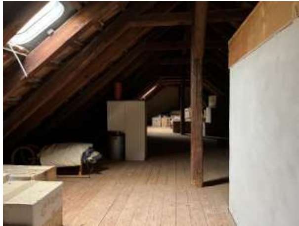
Foto 33: nichtausgebauter Dachraum Teil 1
