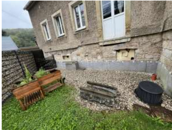
Foto 9: traufseitige Ansicht Gebäude 2 – fertigzustellende Isolierung
