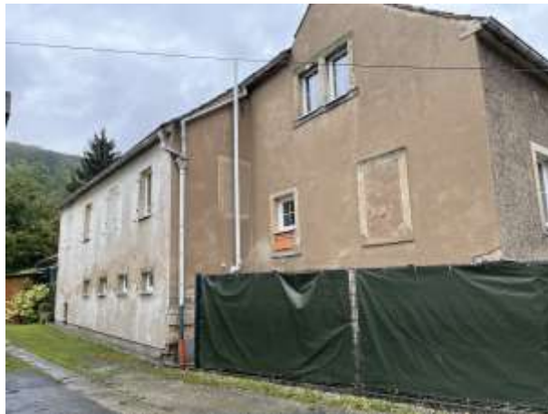
Foto 7: rückwärtige Ansicht aus Nordwesten
