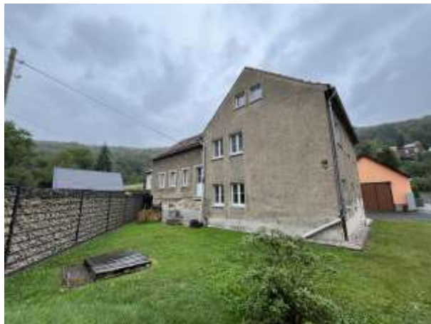
Foto 4: Ansicht aus Westen (links Gebäude 2)
