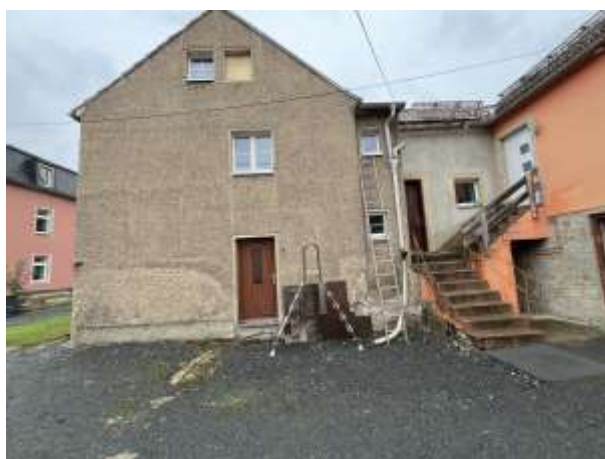
Foto 5: hofseitige Ansicht links Gebäude 1, Mitte Gebäude 2, rechts Gebäude 3
