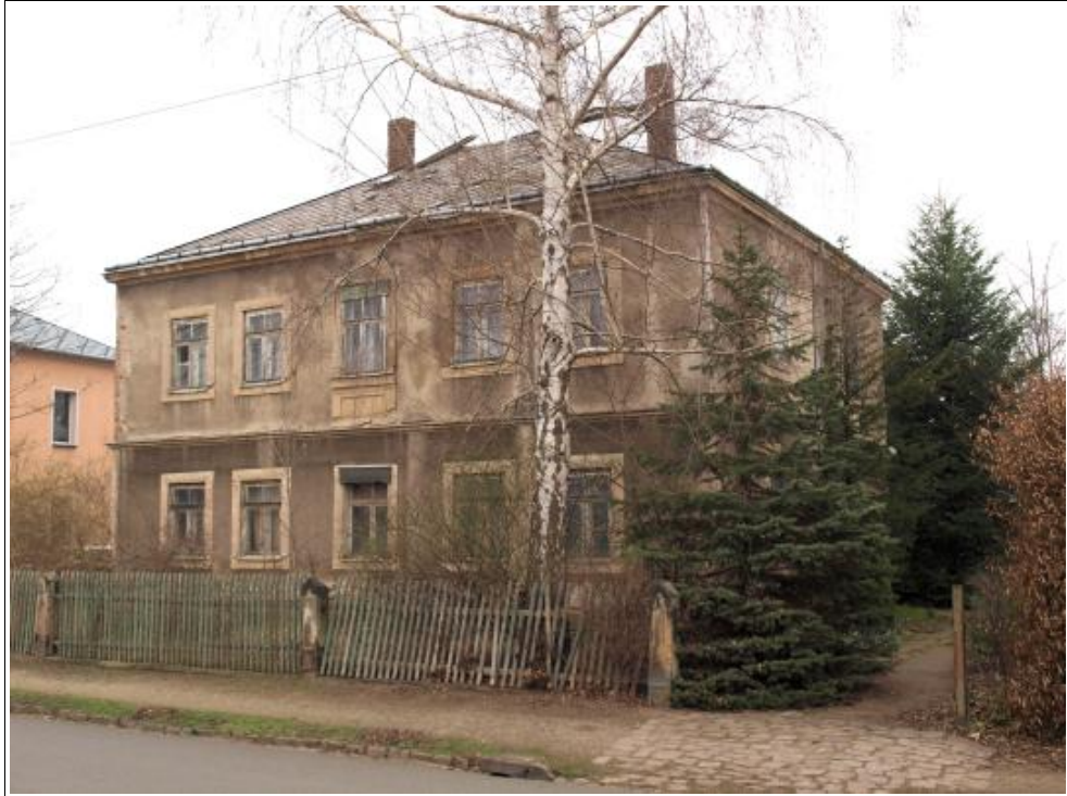
Abbildung 10: straßenseitige Ansicht mit Zufahrt aus Richtung Osten
