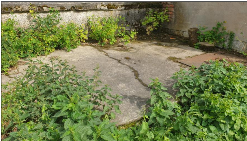
Foto 13: Klärgrube an westlicher Gebäudeseite
