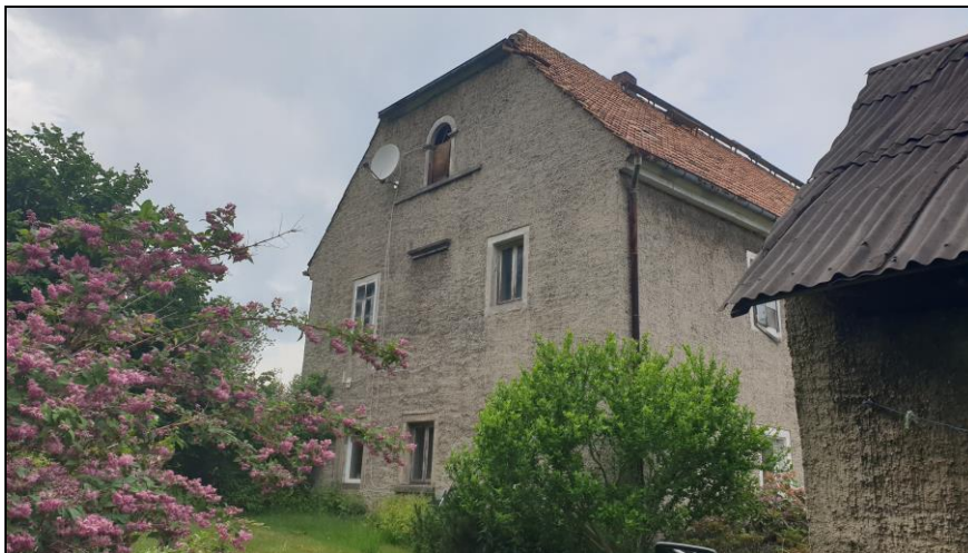
Foto 6: giebelseitige Ansicht Süden – Wohnhaus
