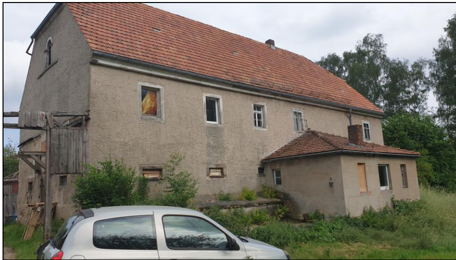
Foto 8: traufseitige Ansicht aus Nordwesten – Wohnhaus (Nr.1)
