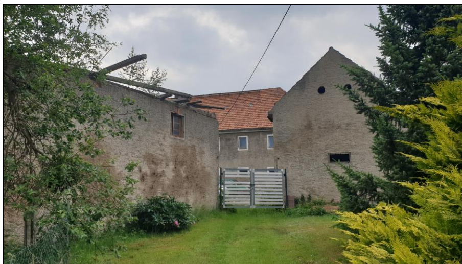
Foto 4: Eingang zum Grundstück über Flurstück 21
