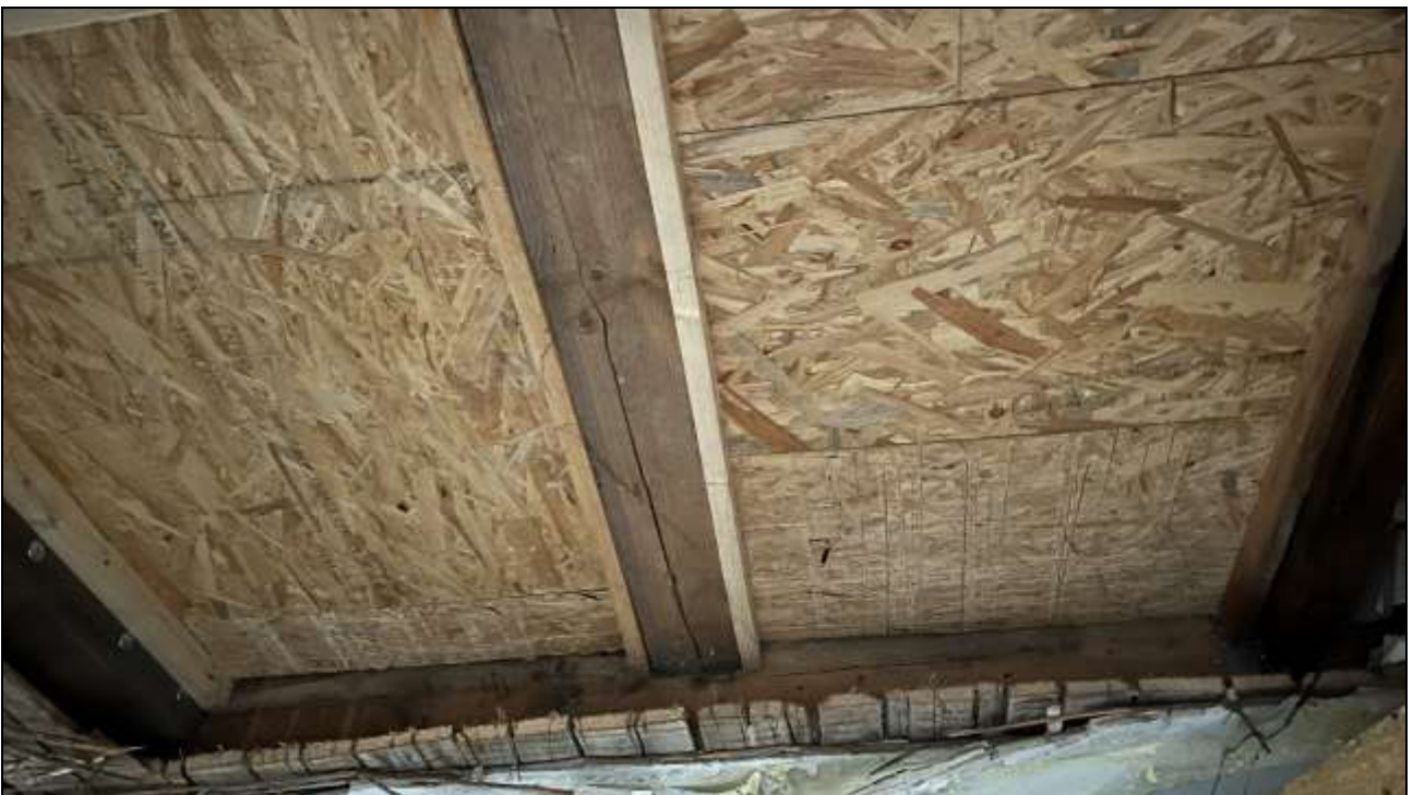
Foto 16: provisorischer Deckenschluss
