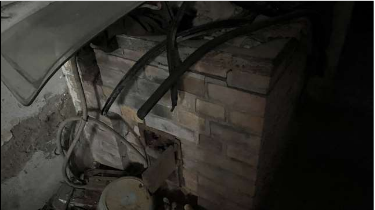
Foto 9: Blick in den Keller - Schornstein
