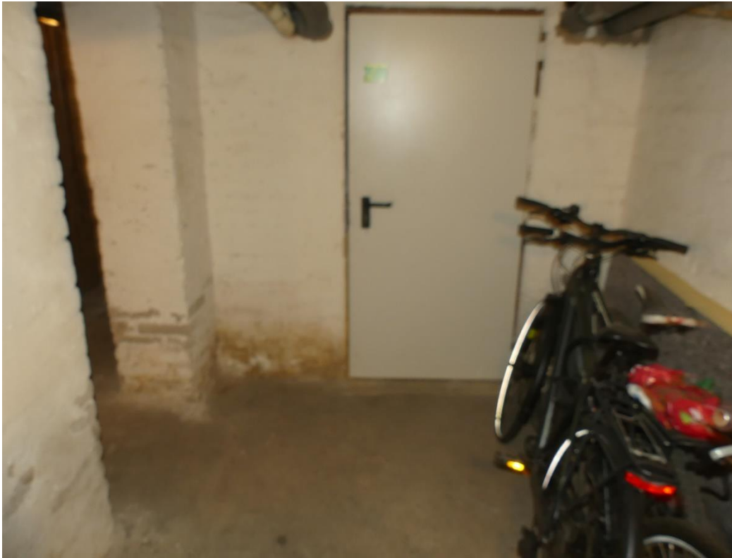
Foto 11: Zugang zum Heizraum
