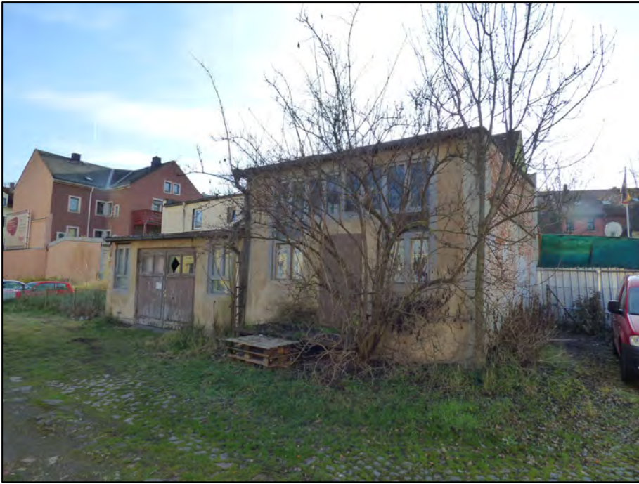
Blick auf die beiden Nebengebäude
