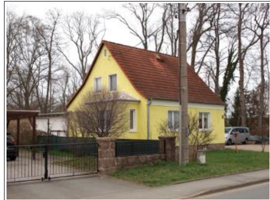
straßenseitige Ansicht aus Richtung Süden
