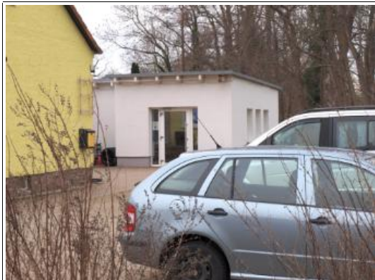
straßenseitige Teilansicht, im Hintergrund Eingangsbereich z. eingeschossigen Anbau
