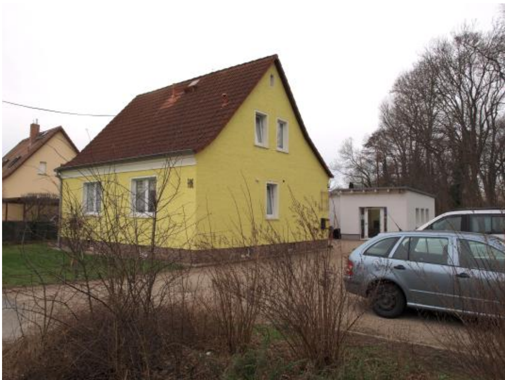
Abbildung 15: straßenseitige Ansicht, im Hintergrund Eingangsbereich zum eingeschossigen Anbau
