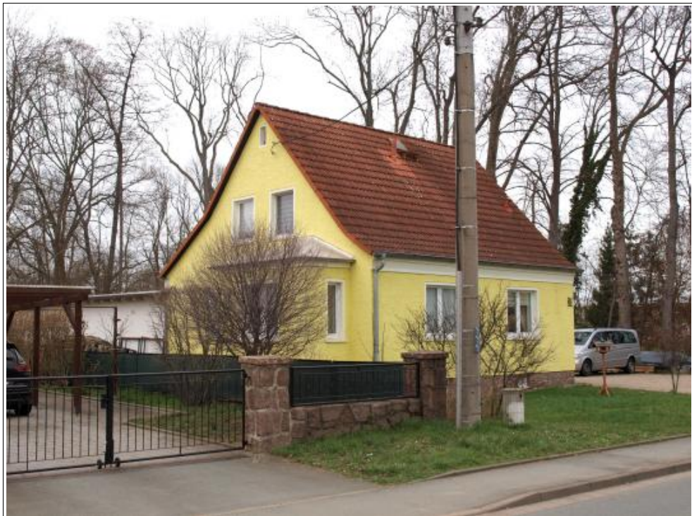
Abbildung 13: straßenseitige Ansicht aus Richtung Süden
