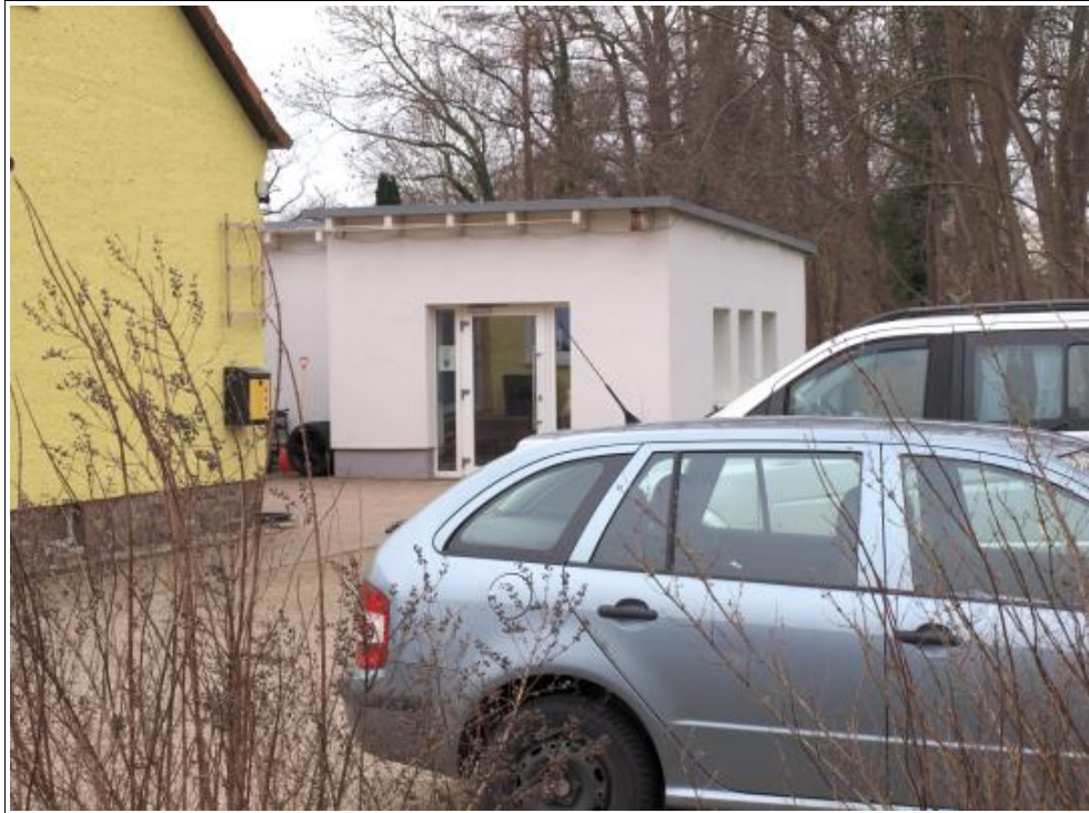
Abbildung 14: straßenseitige Teilansicht, im Hintergrund Eingangsbereich zum eingeschossigen Anbau
