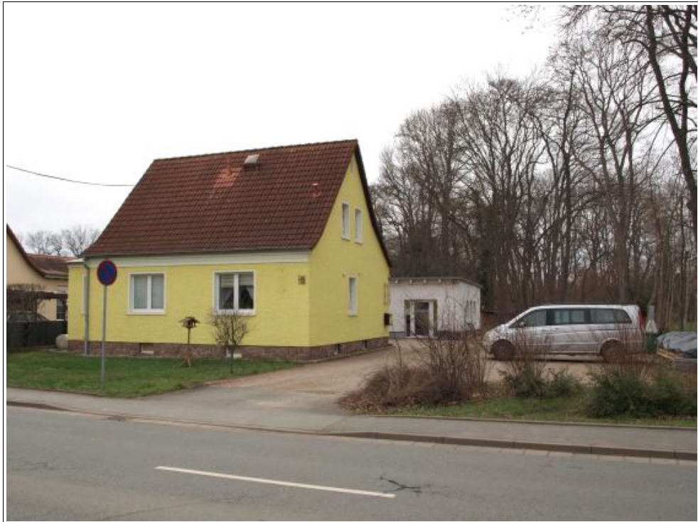
Abbildung 12: straßenseitige Ansicht aus Richtung Südost
