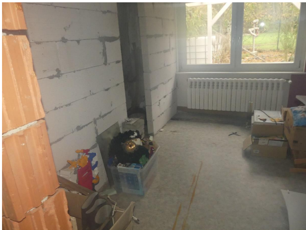
Foto 6: Raum im Umbau begriffen
