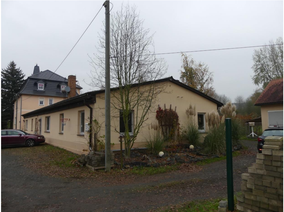
Foto 1: Straßenansicht Döbelner Straße 25
