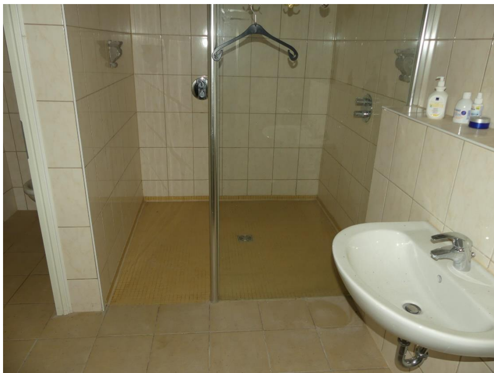
Foto 20: Bad im Obergeschoss Döbelner Straße 25a
