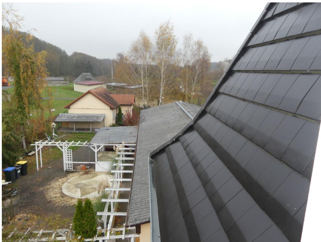
Foto 28: Blick vom Dachgeschoss Döbelner Straße 25a nach Westen auf den Flachbau Döbelner Straße 25
