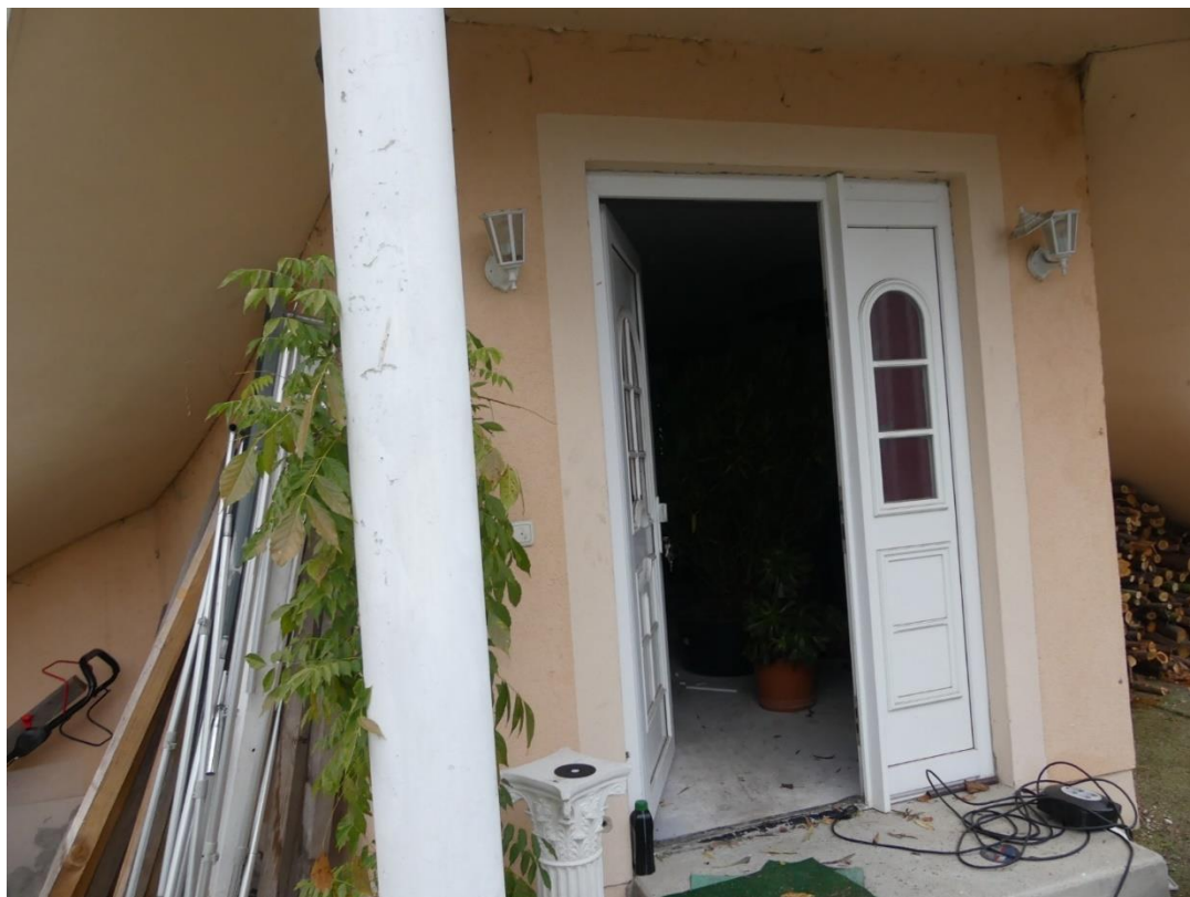
Foto 14: Hauseingang Erdgeschoss Döbelner Straße 25a
