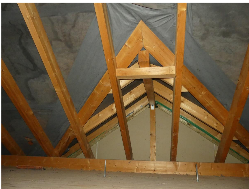
Foto 27: Dachboden Döbelner Straße 25a
