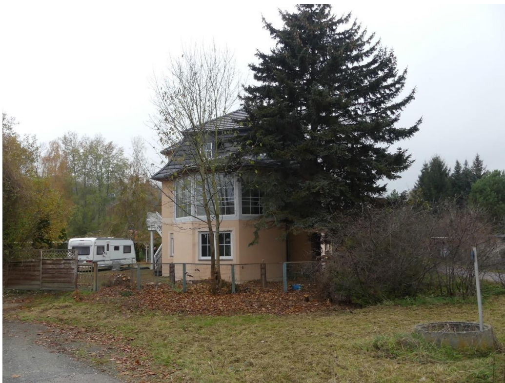
Foto 12: Ostseite Döbelner Straße 25a
