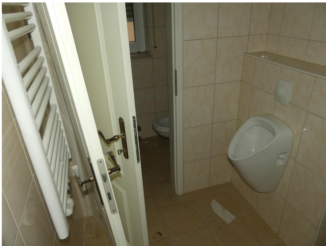
Foto 17: Bad im Erdgeschoss Döbelner Straße 25a
