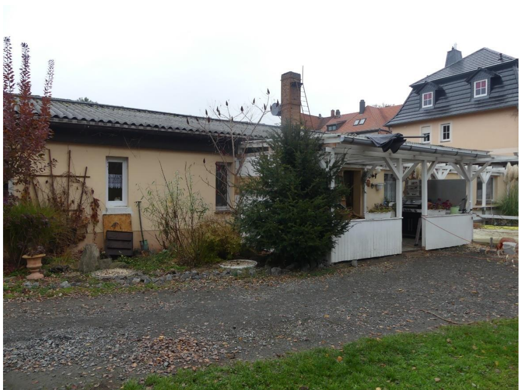
Foto 2: Rückseite Döbelner Straße 25 mit überdachter Terrasse
