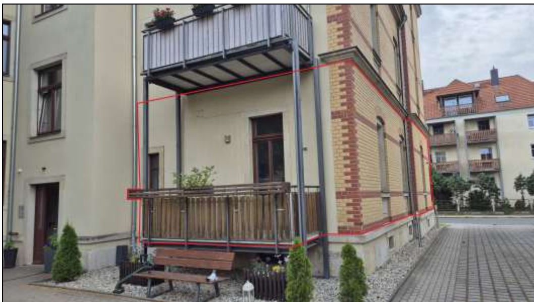
FOTO 4: hofseitige Ansicht aus Osten
